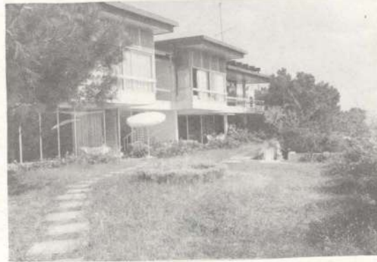
Terasda kesintisiz görüş sağlamak amacıyla saçığın üstte yer atan çelik kirişlemeye asılması (Burgaz ikiz ev)
