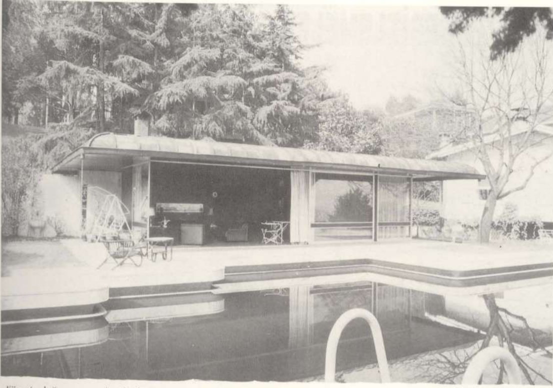
Köşenin doğramaya açıklığıyla (sürme kanatlar) iç ve dış mekanı birleştirmesi (Yeniköy'de bahçe pavyonu)
