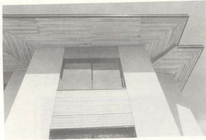
Saçak kaplamanın meyilli olarak detaylanması (Yeniköy konut)
