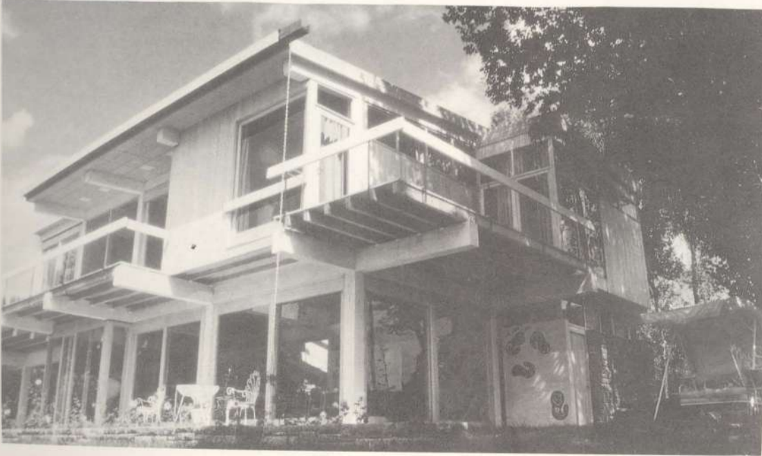
Köşede betonarme taşıyıcılarla ahşap öğelerin ilişkisi (Pendik'te yalı)
