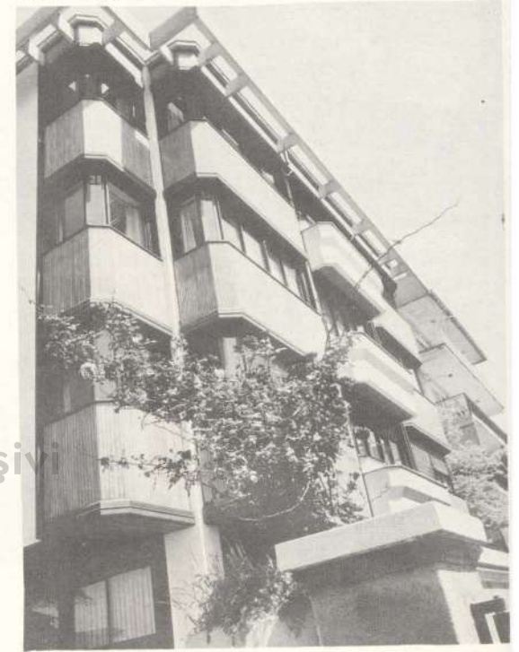
Saçak yüzeyinin ışık geçirme ve havalandırma ilkesi uyarınca detaylanması (Maçka'da konut/B.A. kirişe asılan prekast öğeler)
