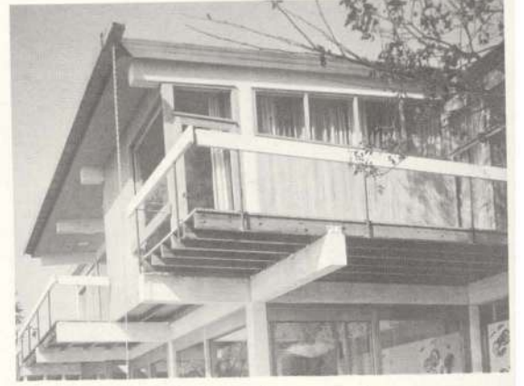
Derenin metal öğelerle saçak ucuna asılması (Pendik'te yalı)
