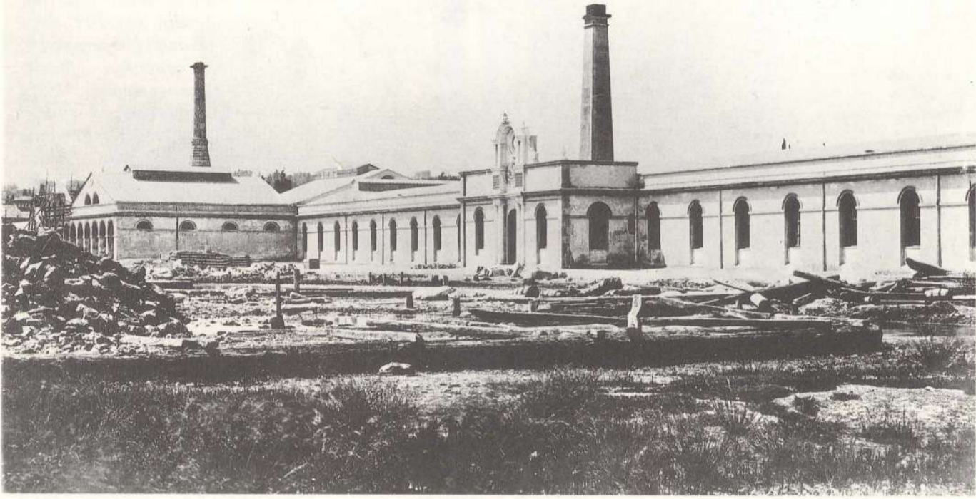
"Feshane", "Fes ve Melbusat-ı Askeriye Fabrikası'nın buhar kazanları binasının yapım yılları
