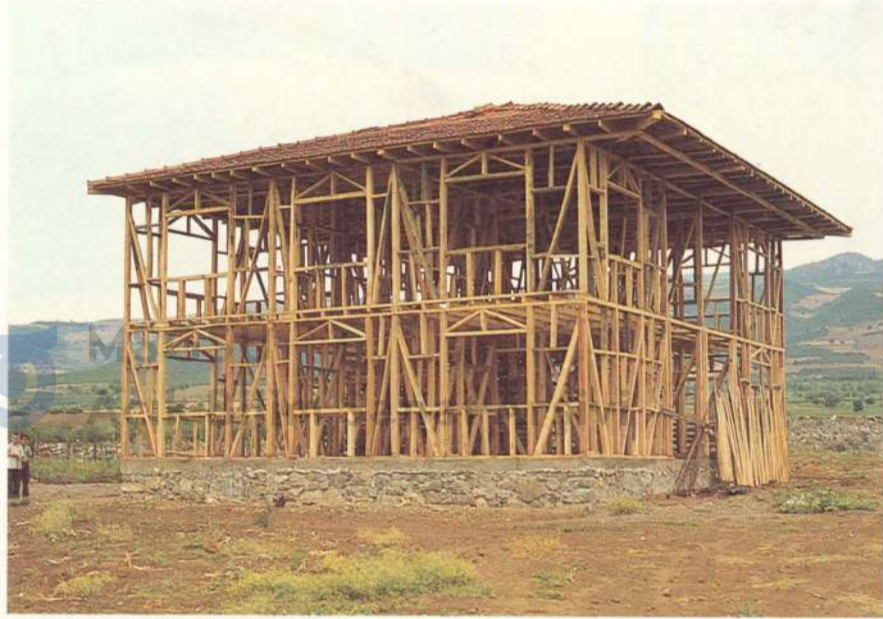
Anadolu'daki geleneksel hafif yapı sistemi ve bu sisteme göre yapılmış evler. Marmara Bölgesi, 1965
