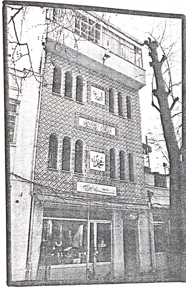
(Fot.3.2-10) İskele çarşısında camii
