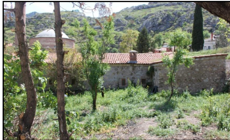
Resim 27: Amasya Ayas Ağa Medresesi kuzey cephesi (2014).
