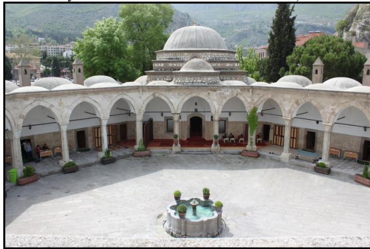
Resim 21: Amasya Kapı Ağası Medresesi güneydoğu, güney ve güneybatı cephe revakları (2014).
