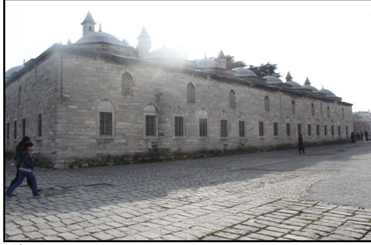
Resim 82: İstanbul Sultan II. Bayezit Medresesi kuzey cephesi (2014).
