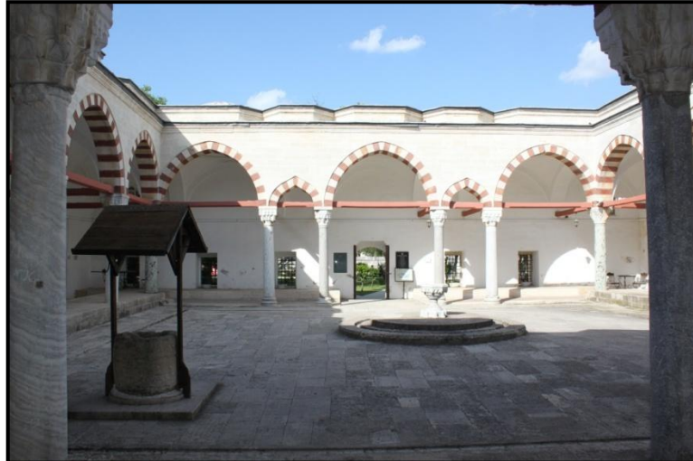
Resim 45: Edirne Sultan II. Bayezit Medresesi doğu cephe revakları (2014).
