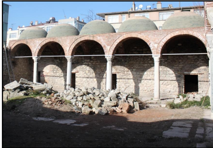
Resim 55: İstanbul Davut Paşa Medresesi kuzey cephe revakları (2014).
