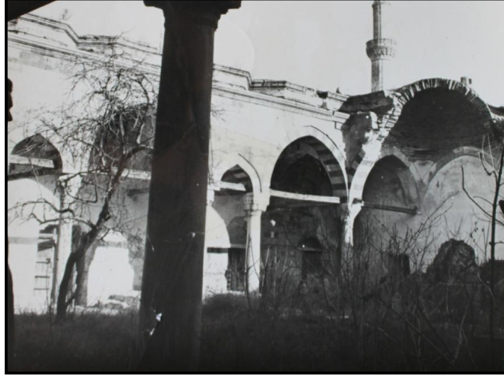
Resim 44: Edirne Sultan II. Bayezit Medresesi doğu cephe revaklarının restorasyon öncesi görünümü (Edirne Kültür Varlıklarını Koruma Bölge Kurulu Arşivi'nden).
