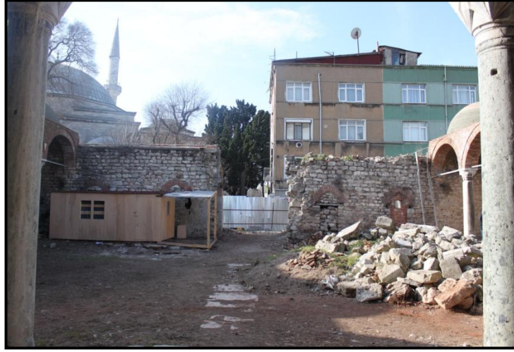
Resim 53: İstanbul Davut Paşa Medresesi batı cephesinin avludan görünümü (2014).
