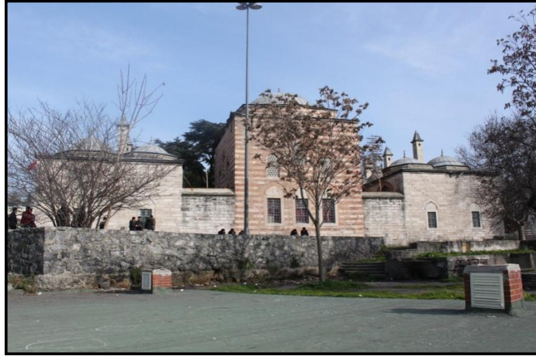
Resim 81: İstanbul Sultan II. Bayezit Medresesi batı cephesi (2014).
