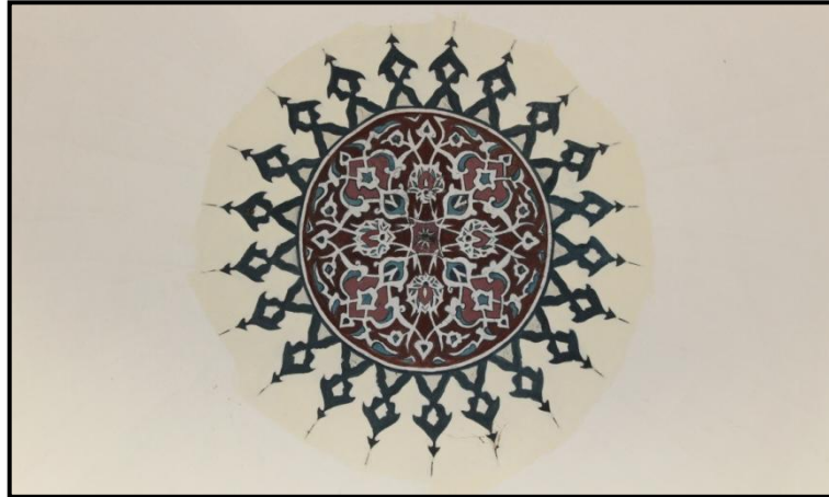
Resim 14: Amasya Sultan II. Bayezit Medresesi derhane mekanı önündeki revak biriminin üst örtüsünde bulunan kalem işi süsleme (2014).
