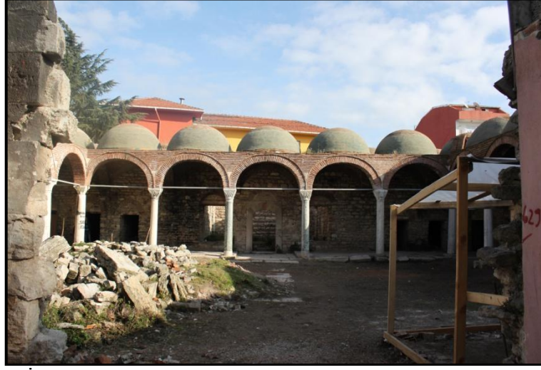
Resim 56: İstanbul Davut Paşa Medresesi doğu cephe revakları (2014).
