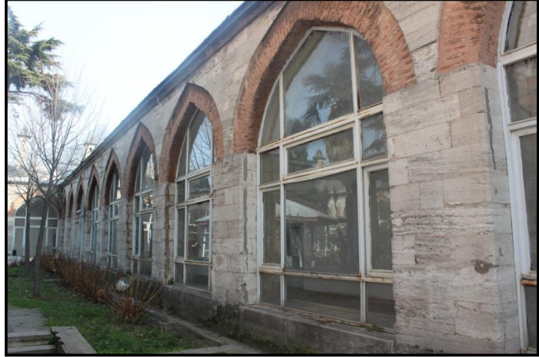
Resim 85: İstanbul Sultan II. Bayezit Medresesi güney cephe revakları (2014).
