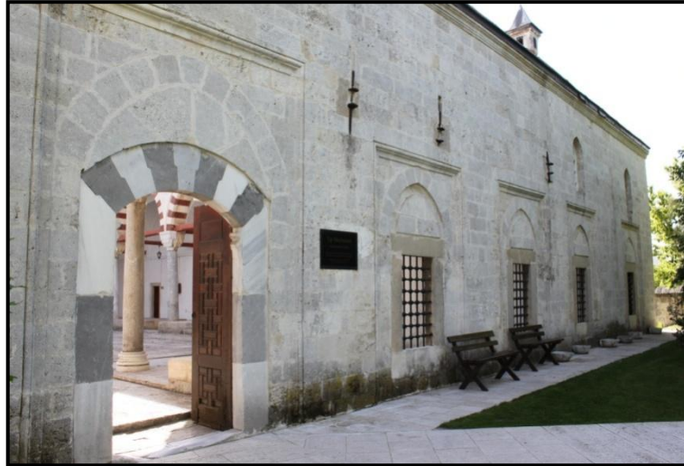
Resim 39: Edirne Sultan II. Bayezit Medresesi doğu cephesi (2014).
