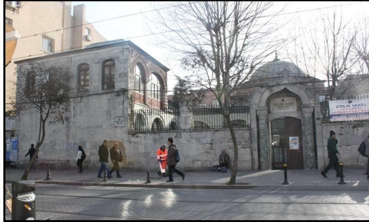
Resim 70: İstanbul Atik Ali Paşa Medresesi kuzey cephesinin doğu bölümü (2014).
