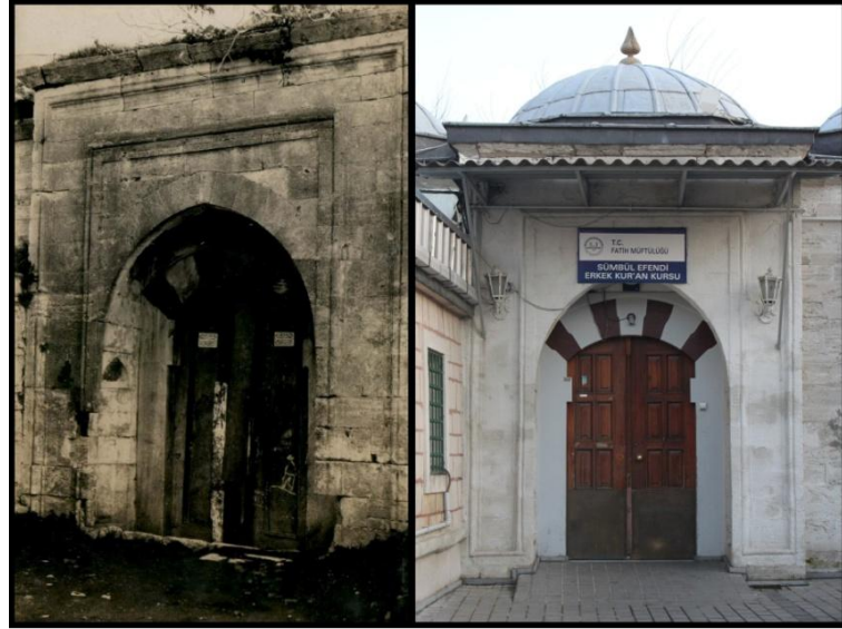
Resim 63: İstanbul Koca Mustafa Paşa Medresesi taç kapısının onarım öncesi ve sonrası görünümü (soldaki fotoğraf İstanbul Vakıflar Bölge Müdürlüğü Arşivi'nden), (sağ, 2014).
