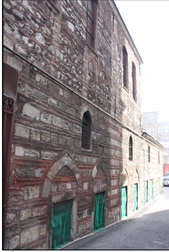
Resim 68: İstanbul Atik Ali Paşa Medresesi batı cephesi (2014).
