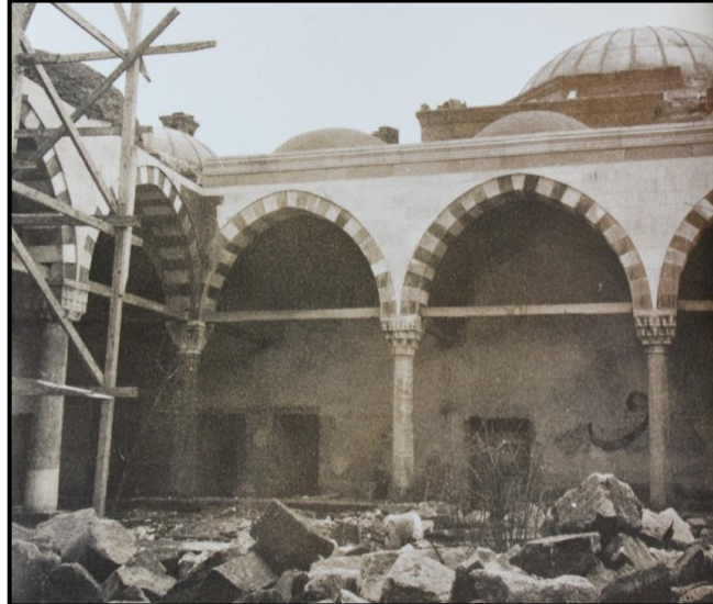
Resim 41: Edirne Sultan II. Bayezit Medresesi batı cephe revaklarının restorasyon öncesi görünümü (Edirne Kültür Varlıklarını Koruma Bölge Kurulu Arşivi'nden).
