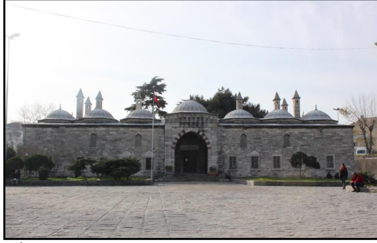
Resim 79: İstanbul Sultan II. Bayezit Medresesi doğu cephesi (2014).
