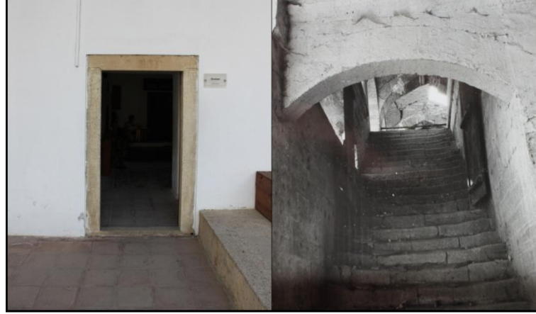
Resim 47: Edirne Sultan II. Bayezit Medresesi derslane mekanı giriş kapısı (solda, 2014), derslane balkon merdivenleri (sağdaki fotoğraf Edirne Kültür Varlıklarını Koruma Bölge Kurulu Arşivi'nden).
