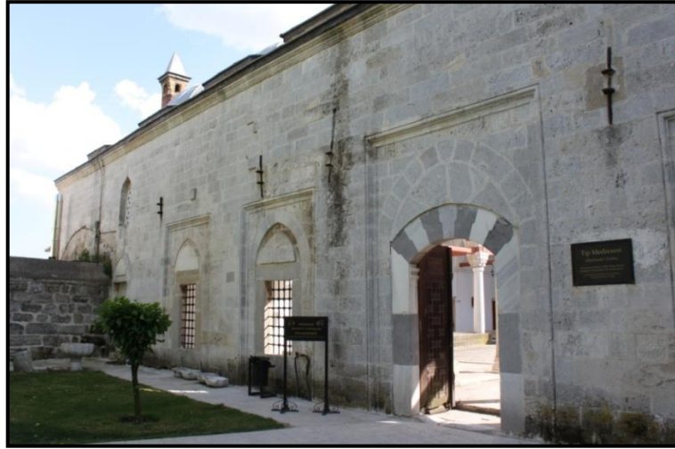
Resim 38: Edirne Sultan II. Bayezit Medresesi doğu cephesi (2014).
