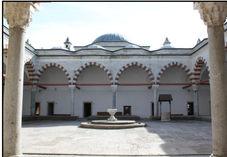
Resim42: Edirne Sultan II. Bayezit Medresesi batı cephe revakları (2014).
