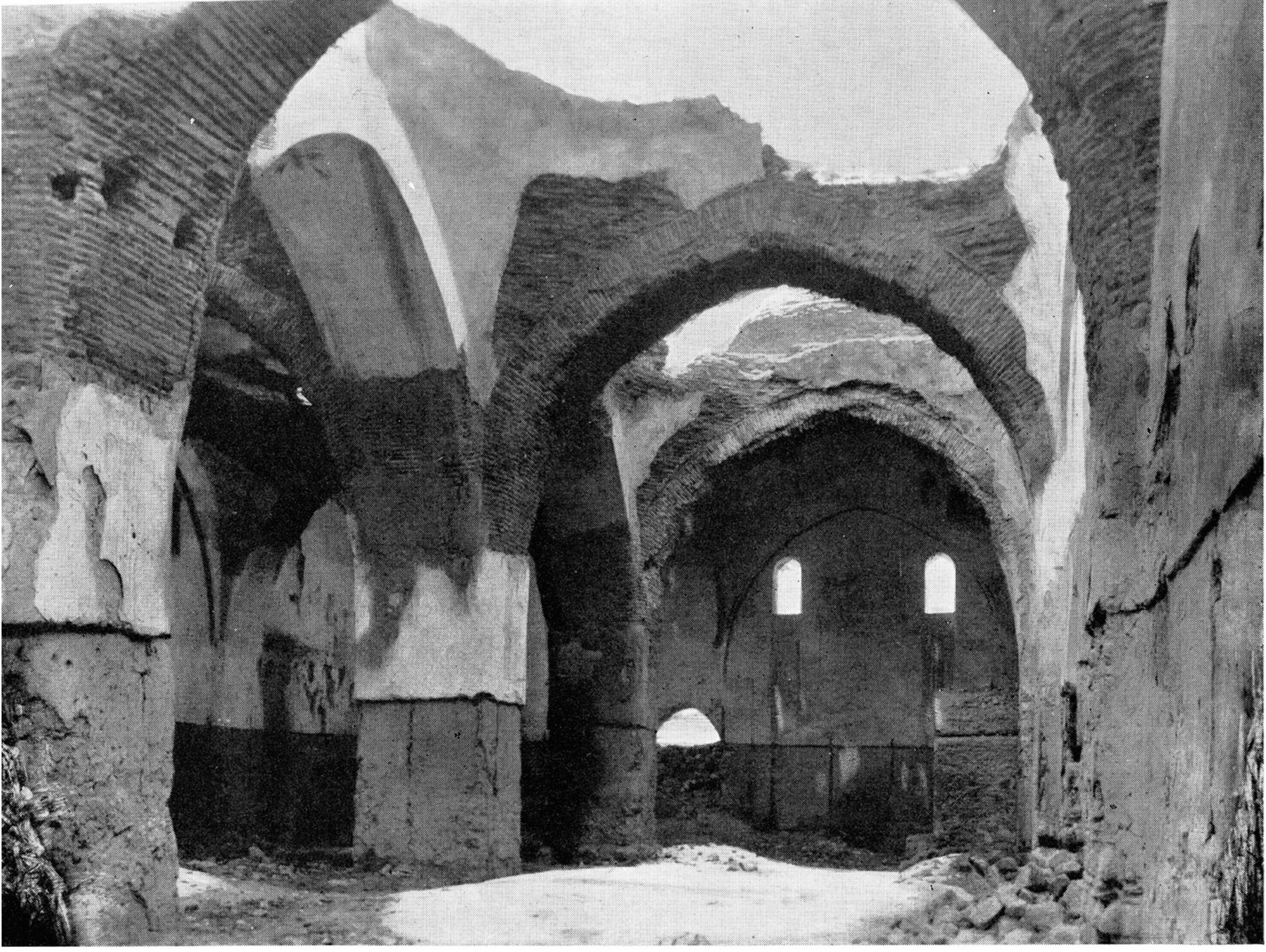
Resim 80: Mahmud Paşa Bedesteni içi (restorasyon öncesi)
