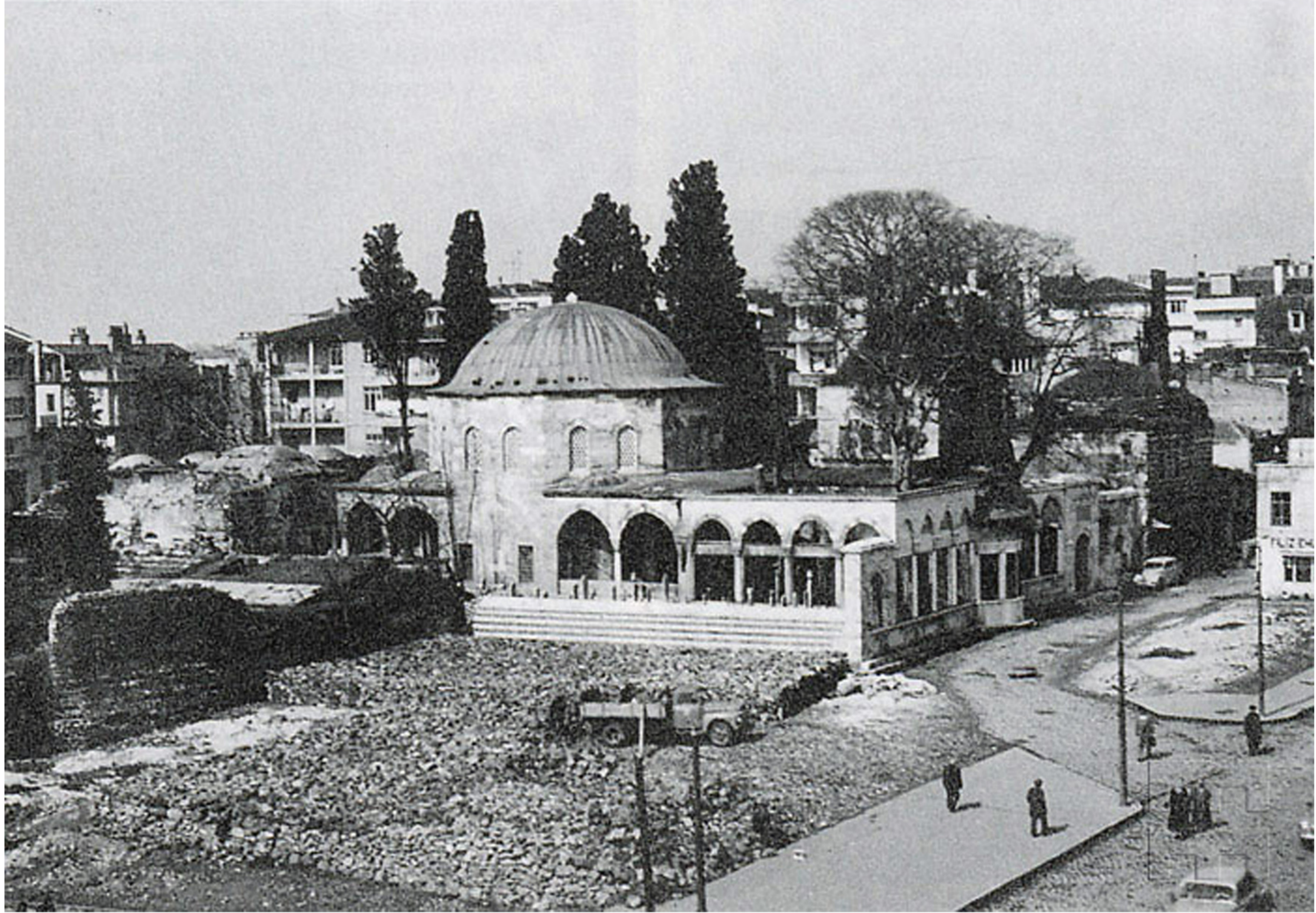
Resim 114: Amcazâde Hüseyin Paşa Medresesi (restorasyondan sonra)
