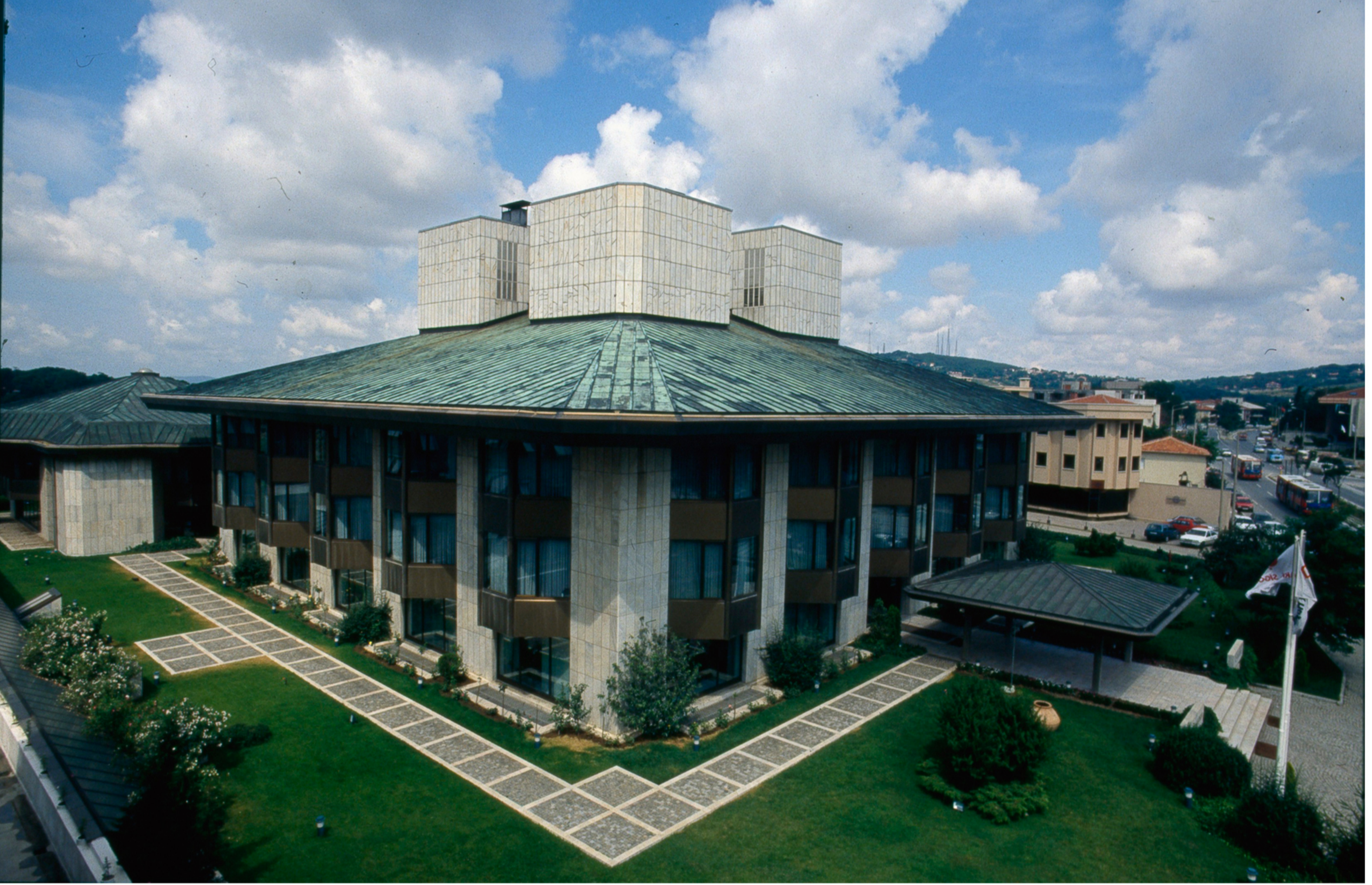
Resim 74: Üsküdar/ Bağlarbaşı'nda Koç Alians Genel Müdürlük Binası
