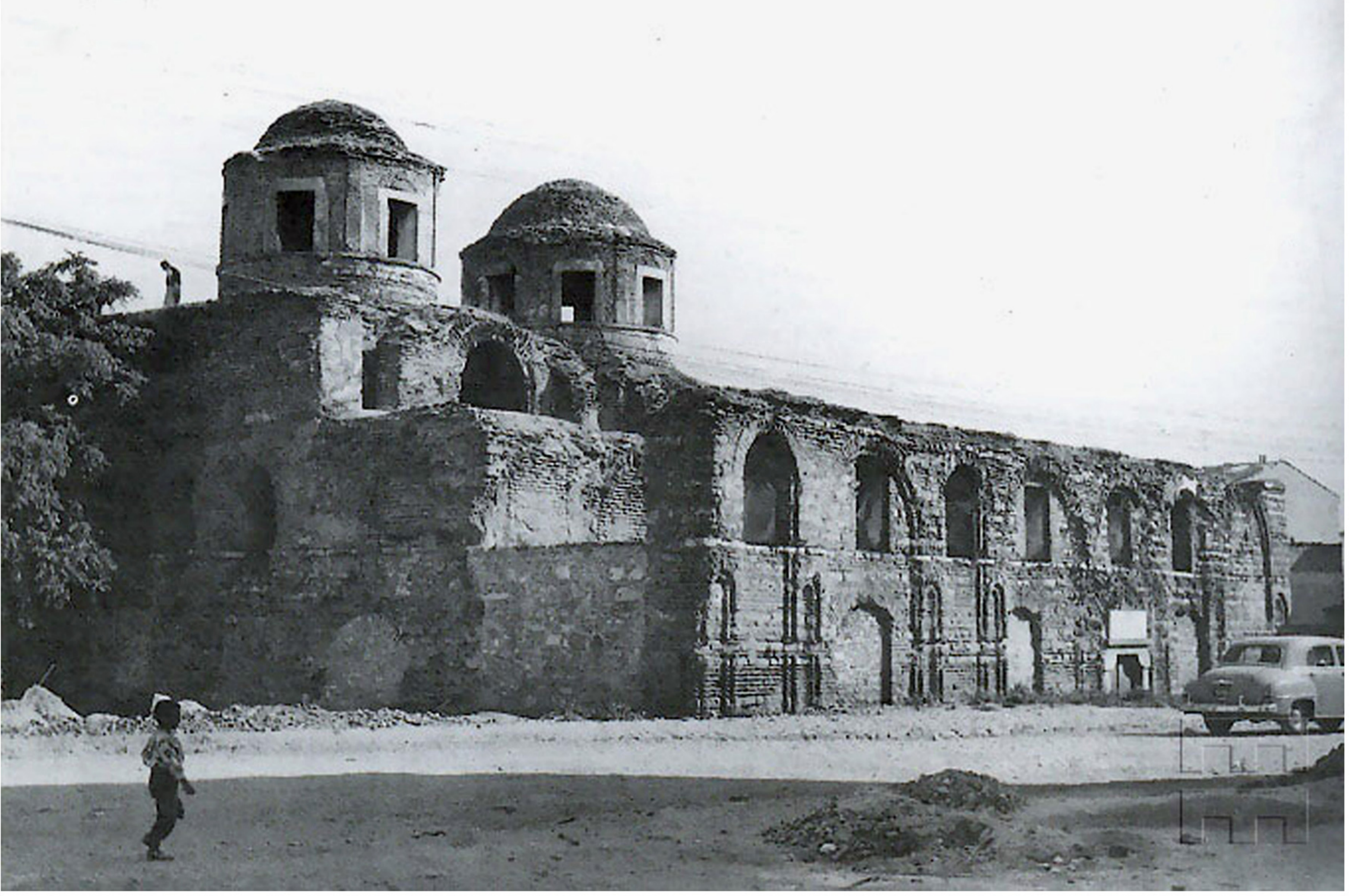
Resim 117: Fenarî İsa Camii (restorasyondan önce)
