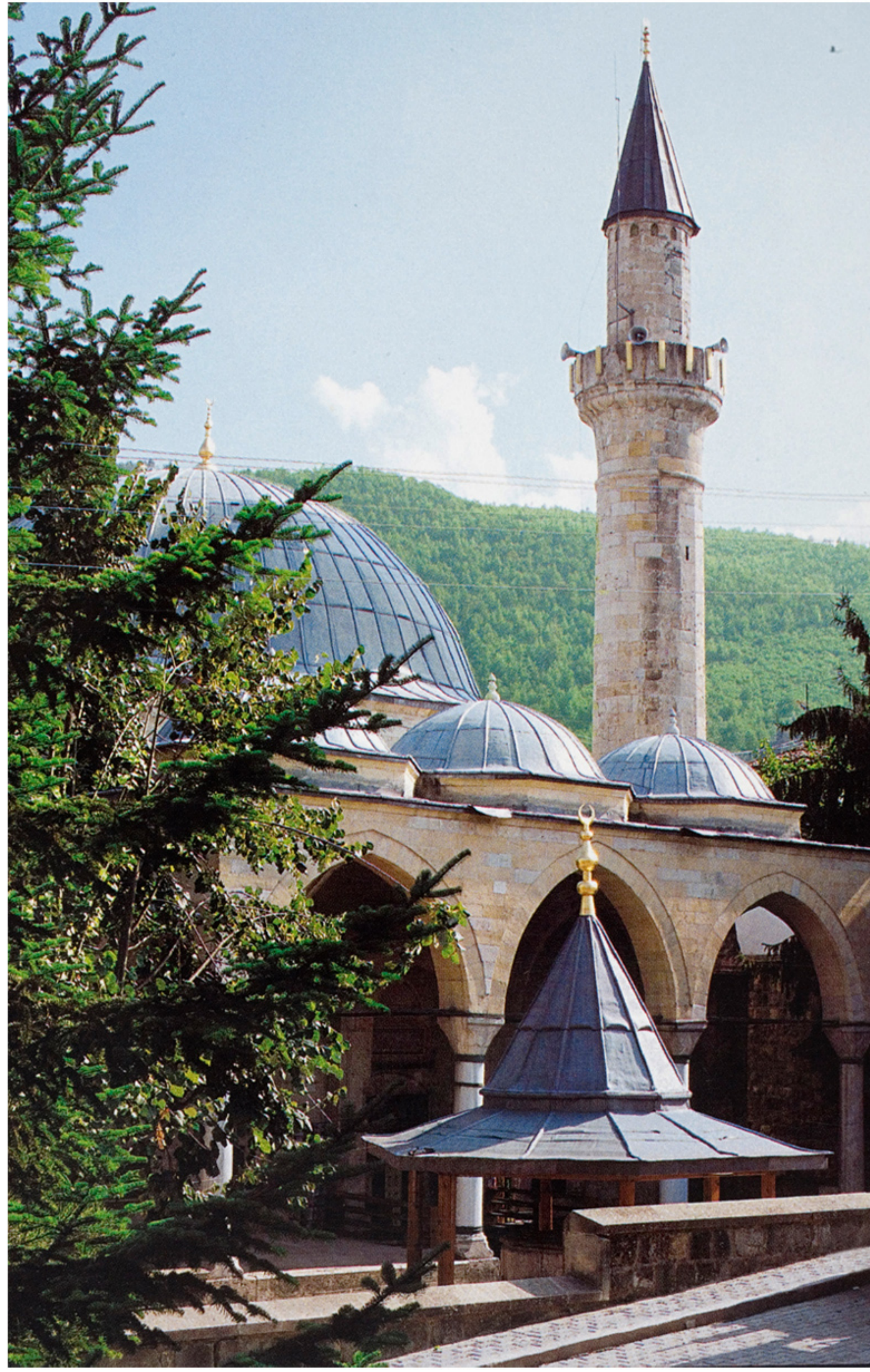
Resim 120: Sakarya Taraklı'da Yûnûs Paşa Camii (restorasyondan sonra)
