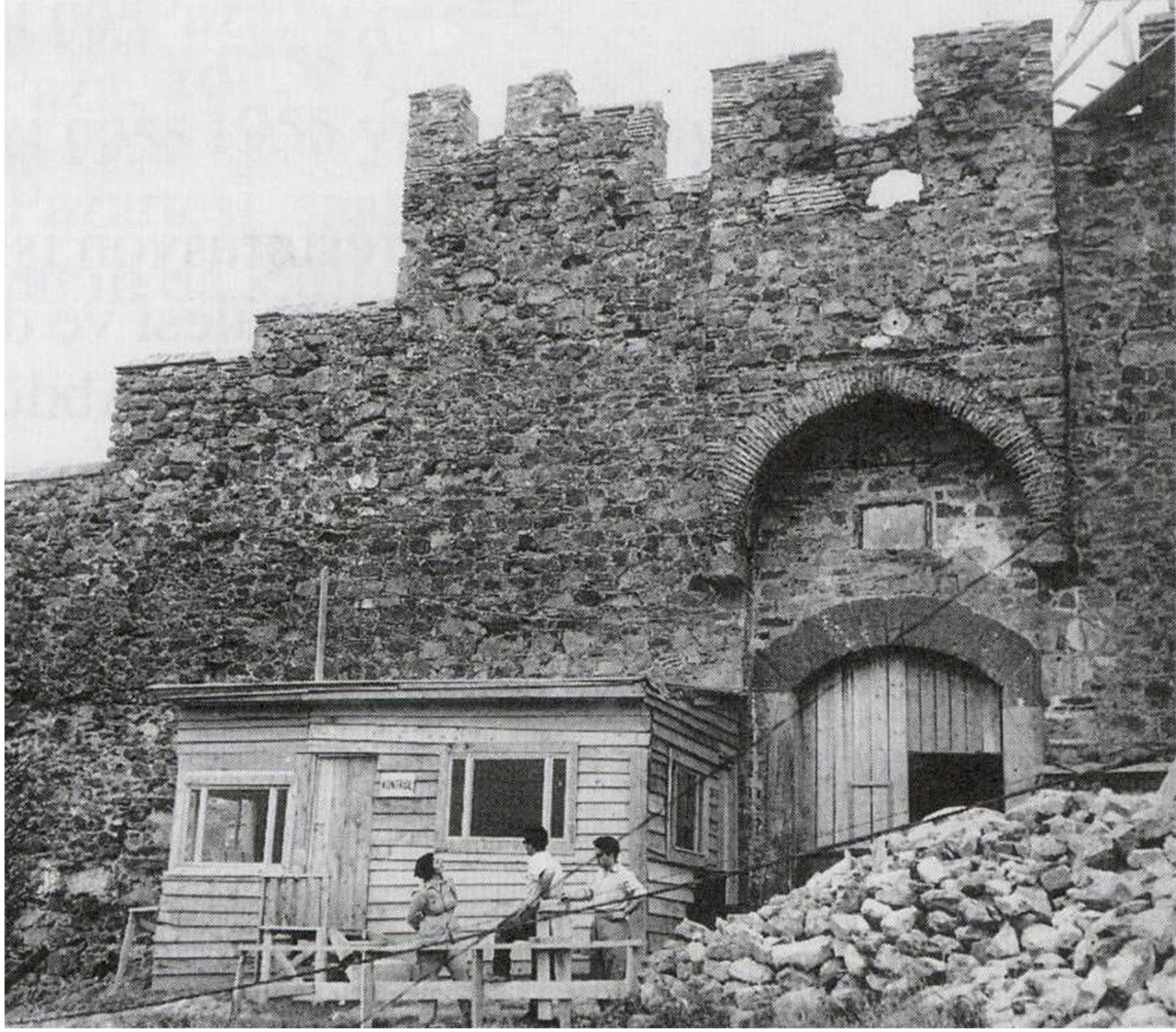
Resim 106: Rumelihisari restorasyonunda hisarın kuzey kapısı ve şantiye
