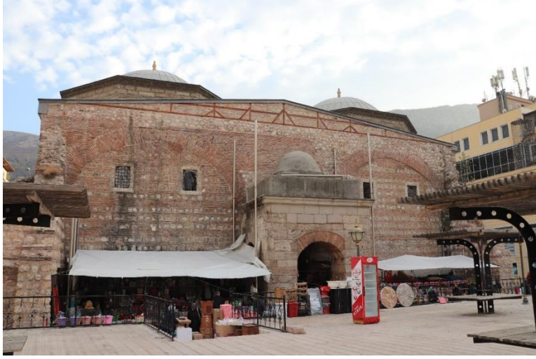
Resim 134: Kapı Ağası Hüseyin Ağa Bedesteni Kuzey Cephesi (2017)
