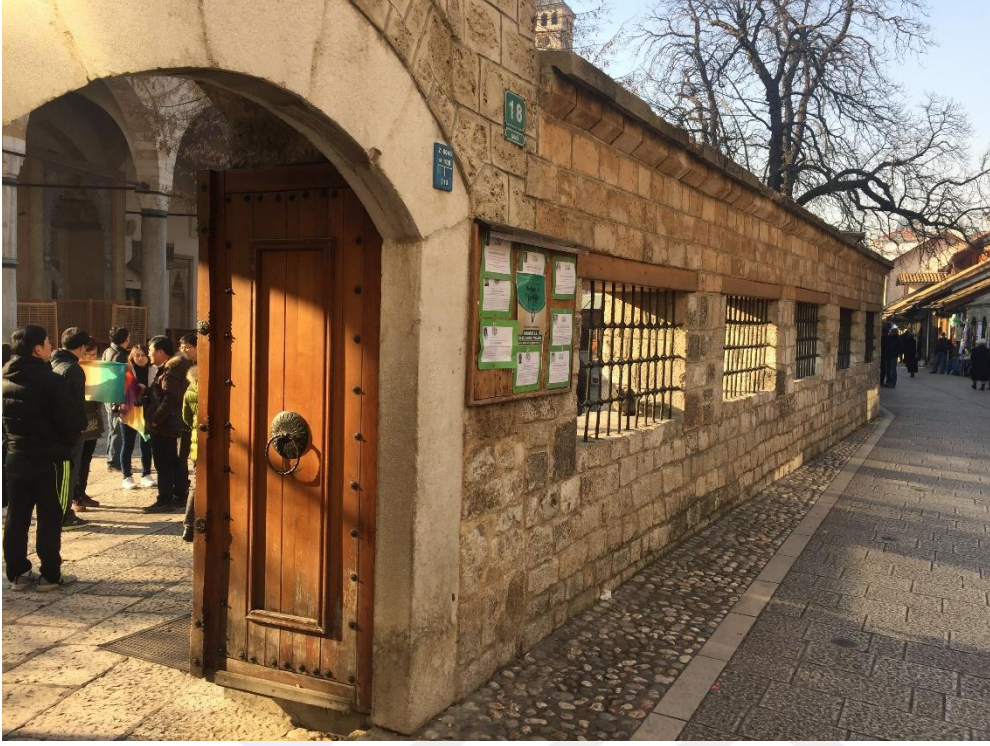
Resim 23: Gazi Hüsrev Bey Cami Avlu Duvarı ve Kapısı (2017)
