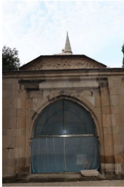
Resim 107: Mehmed Paşa Türbesi Doğu Cephesi (2017)
