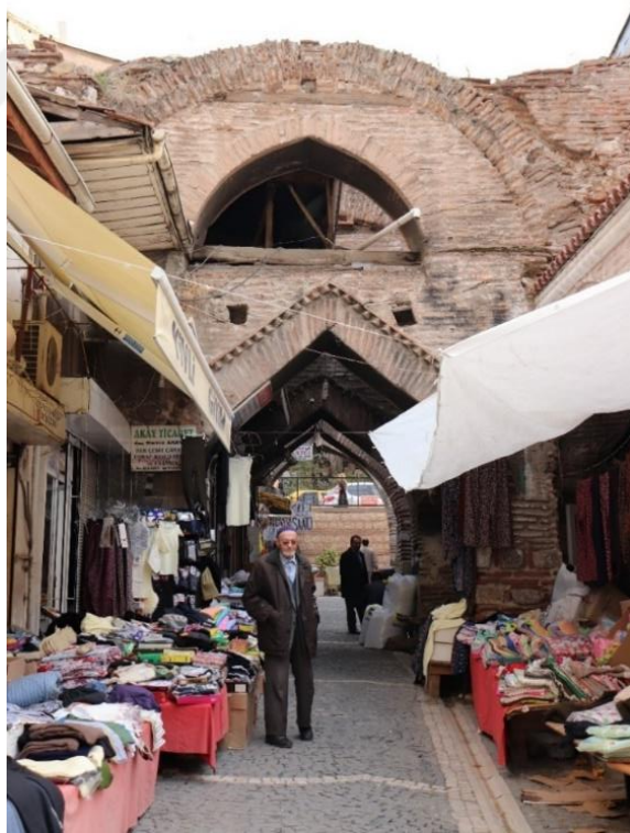
Resim 133: Kapı Ađası Hüseyin Ađa Bedesteninden Görünüm (2017)
