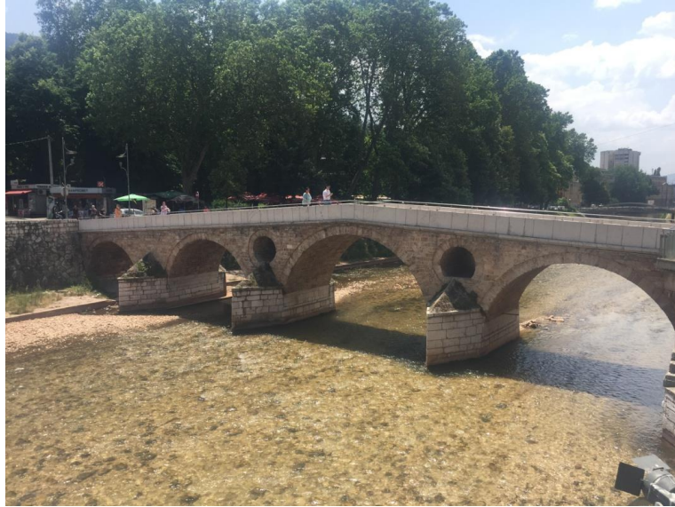
Resim 62: Latin Köprüsü Genel Görünüm (2017)
