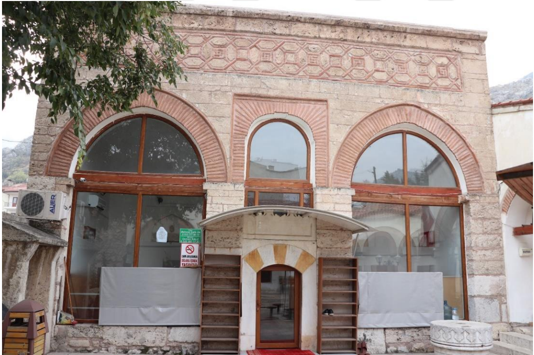
Resim 125: Ayas Ağa Cami Giriş Cephesi (2017)
