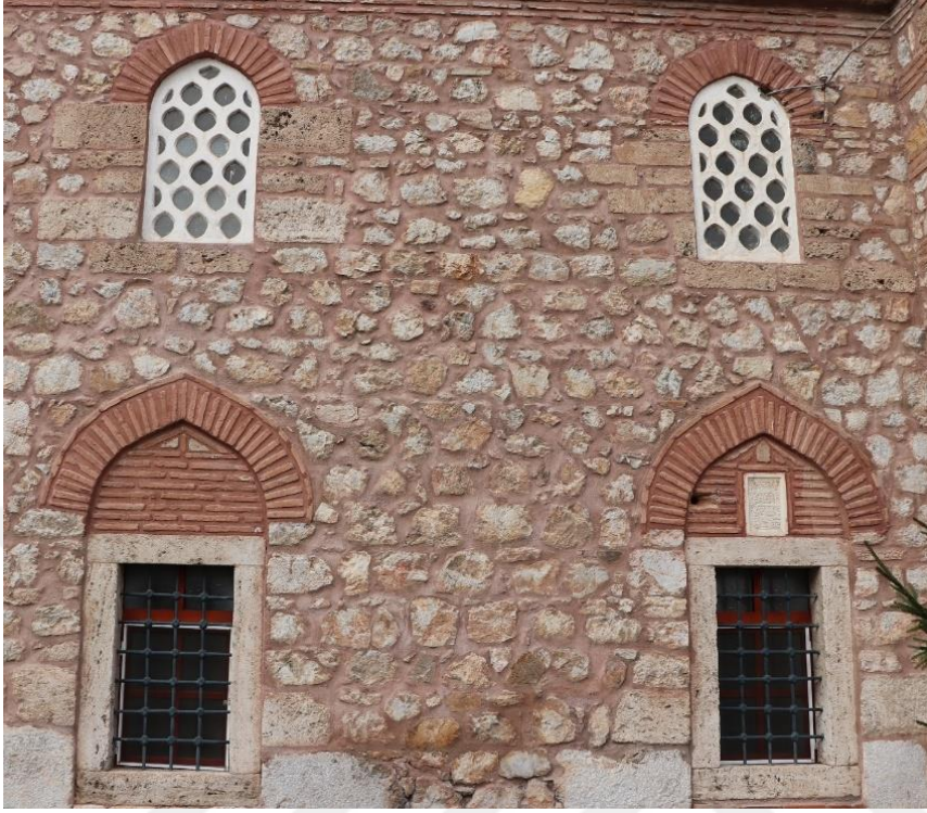
Resim 122: Ayas Ağa Cami Doğu Cephesi (2017)
