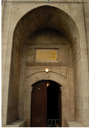
Resim 68: Yakup Paşa Zaviyesi Cümle Kapısı
