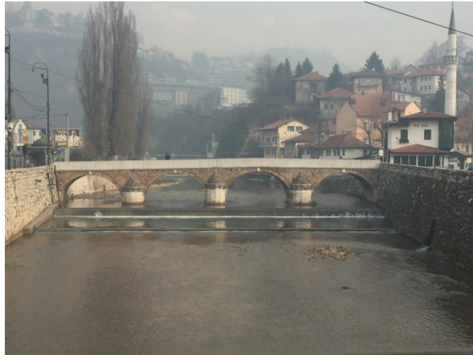
Resim 65: Şehir Çehaya Köprüsü Genel Görünüm (2017)
