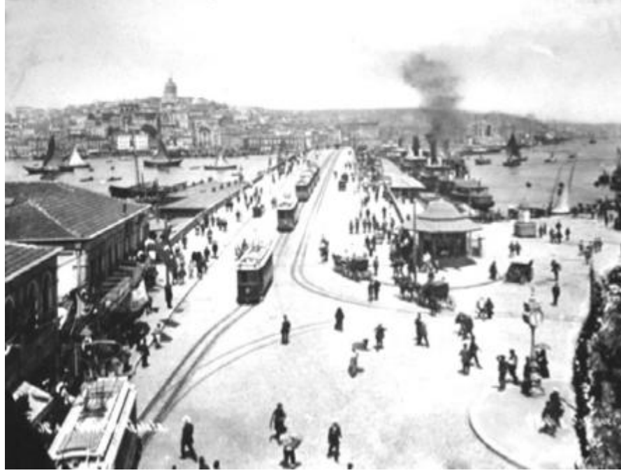
Şekil 4.28. Galata Köprüsü, Eminönü Meydanı ve Elektrikli Tramvay (Eski İstanbul Resimleri, www.34tr.com, 2004)
