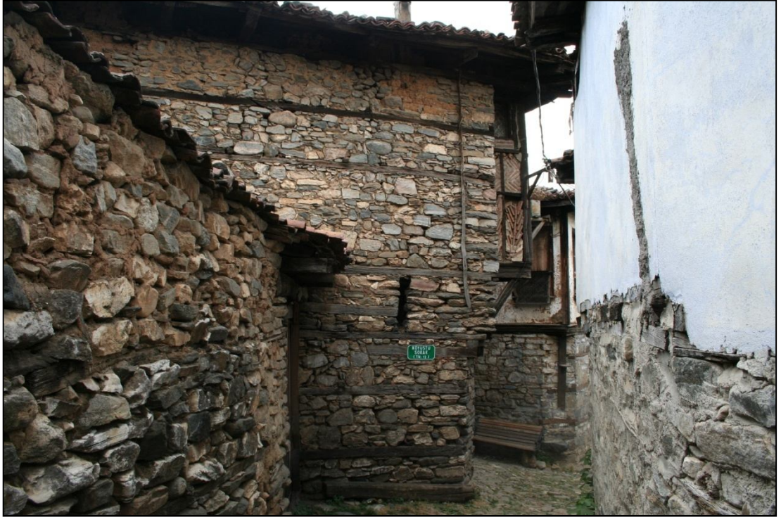
Fotoğraf 97: Yapının ahşap hatıllarla desteklenmiş taş yığma yan duvarı
