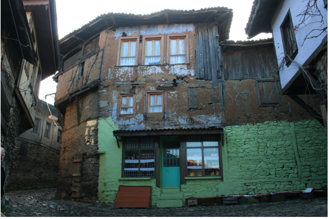
Fotoğraf 100: Evin kuzey cephesi
