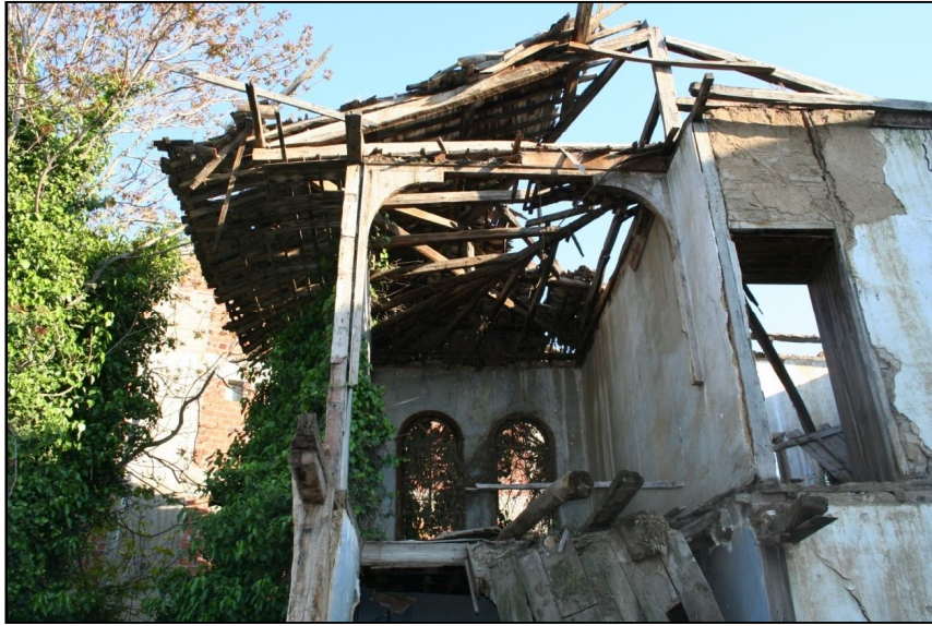
Fotoğraf 111: Ahşap çatı sistemi ve kemerli sofa pencereleri (Mayıs 2010)
