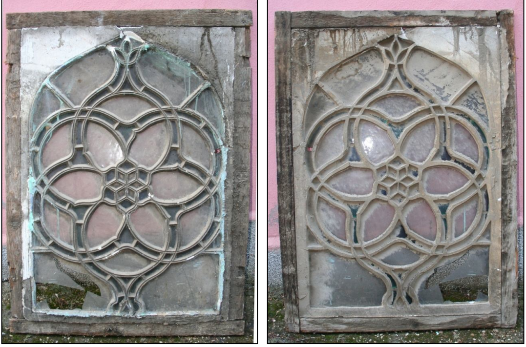
Fotoğraf 138: Bükücüler Evi içlik tepe penceresi dış ve iç görünümü, pencerenin iç tarafında alçı yüzeylerde kanal açılmamıştır.
