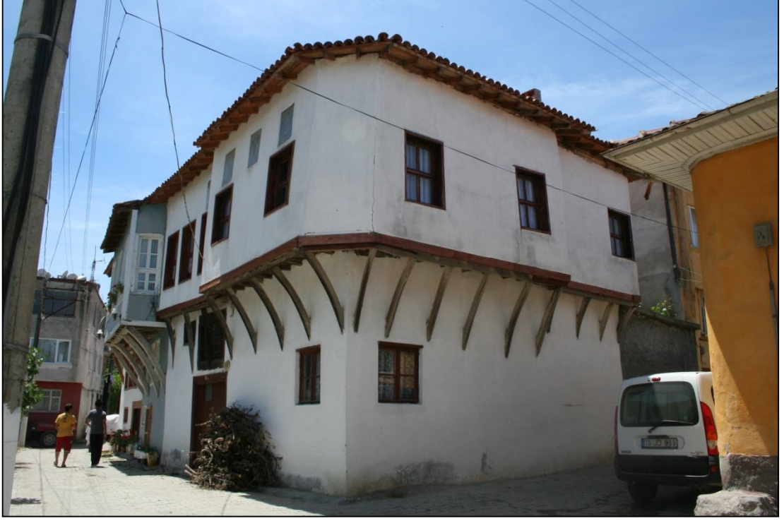
Fotoğraf 86: Evin güneybatı görünümü
