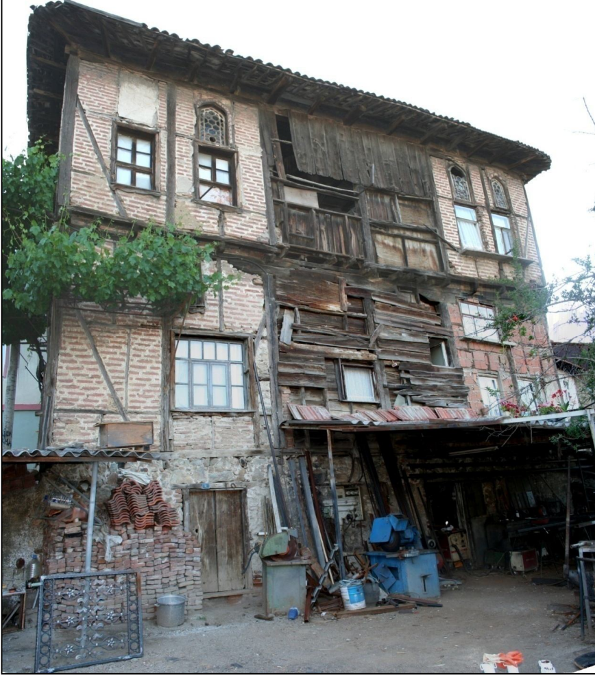
Fotoğraf 28: Kenan Doğruöz evi kuzeydoğu cephesi,
