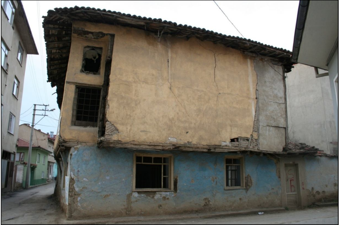
Fotoğraf 43: Yapı dođu cephesi
