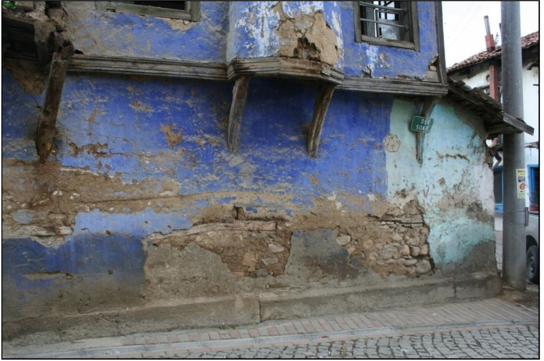
Fotoğraf 35: Zemin kat duvarı, ahşap hatıl altı taş, üzeri kerpiç dolgu olarak yapılmıştır.
