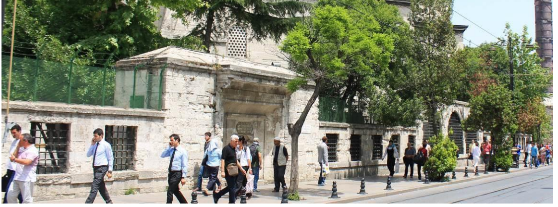
Şekil 4.54 Atik Ali Paşa Camii duvarları günümüz fotoğrafı
