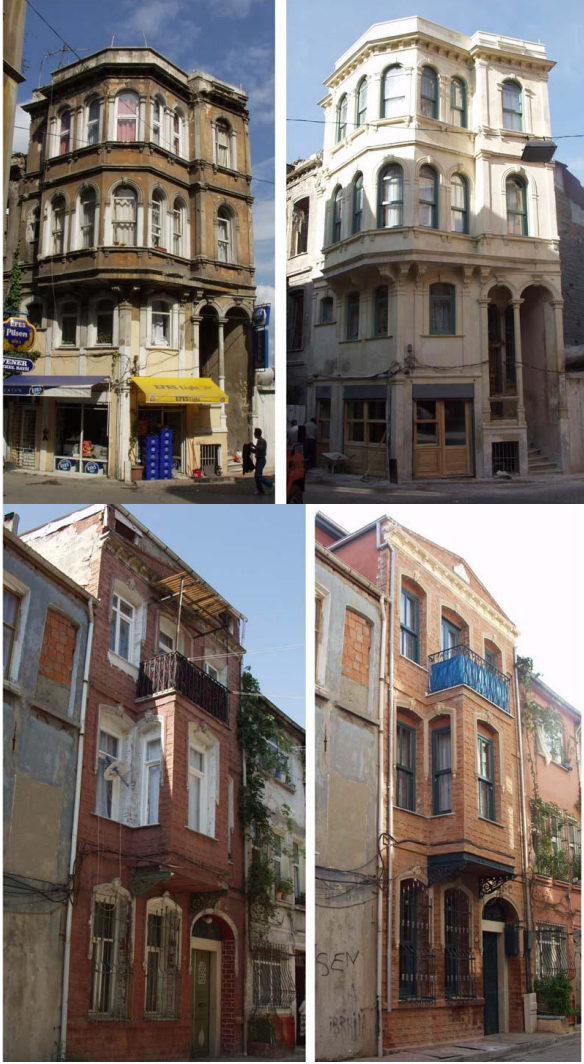
Şekil 4.2: Fener- Balat Rehabilitasyon Projesi Kapsamında Yapılan Restorasyon Uygulamaları (İMP, 2009)
