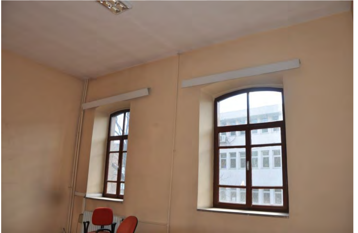
Şekil B.70: 207 Güneydoğu duvarı
