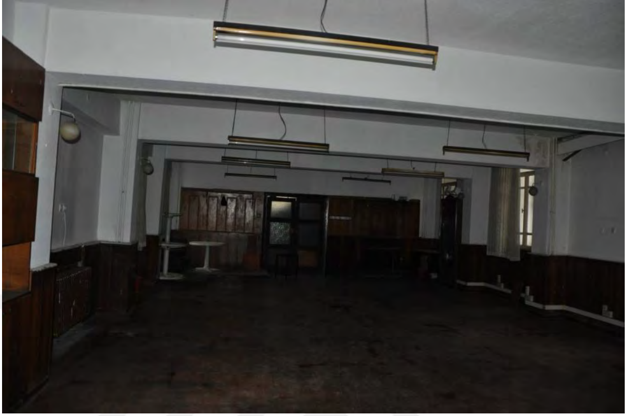
Şekil B.55: 125 Kuzeybatı duvarı
