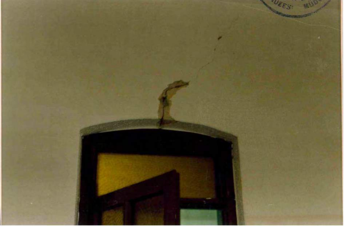
Şekil B.133 : 1999 Depremi Sonrası Oluşan Hasarlar(K.K.V.K.B.Kurul Arşivi)
