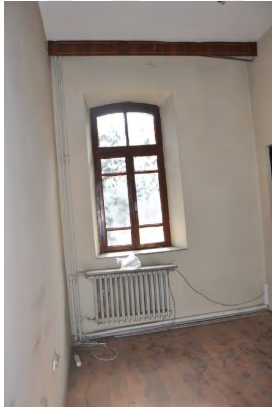
Şekil B.44: 112 Güneydoğu duvarı
