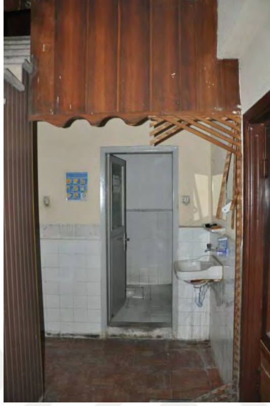
Şekil B.63: 130 Kuzeydoğu duvarı
