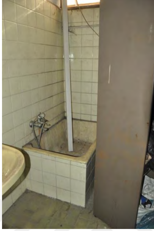
Şekil B.37: 105 Güneydoğu duvarı
