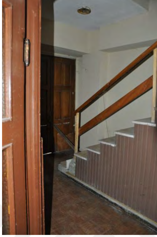
Şekil B.61: 128 Güneybatı duvarı
