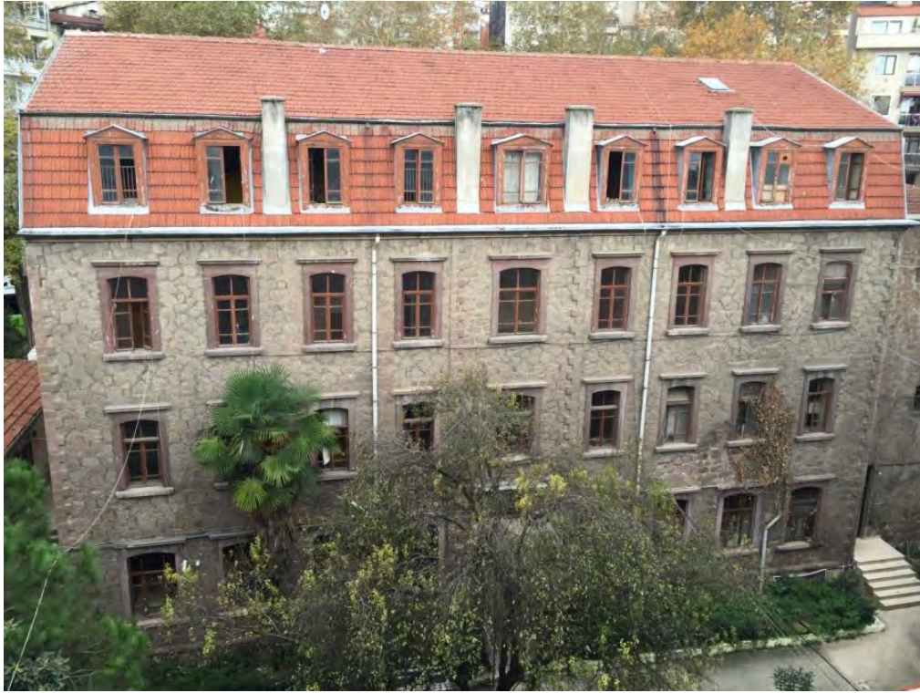
Şekil B.97 : Güneydoğu Cephesi 2018
