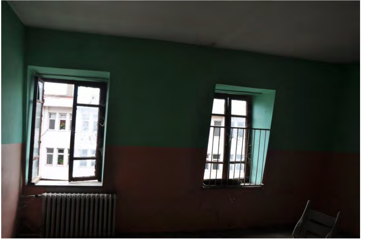
Şekil B.89.A: 310 Güneydoğu duvarı
