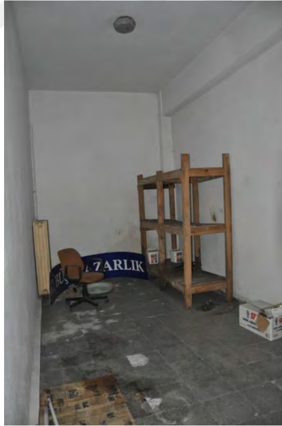
Şekil B.28: Z-16 Güneybatı ve kuzeybatı duvarı
