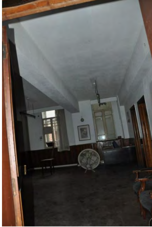
Şekil B.54: 125 Kuzeydoğu duvarı
