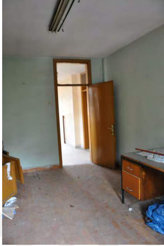
Şekil B.96: 315 Güneydoğu duvarı
