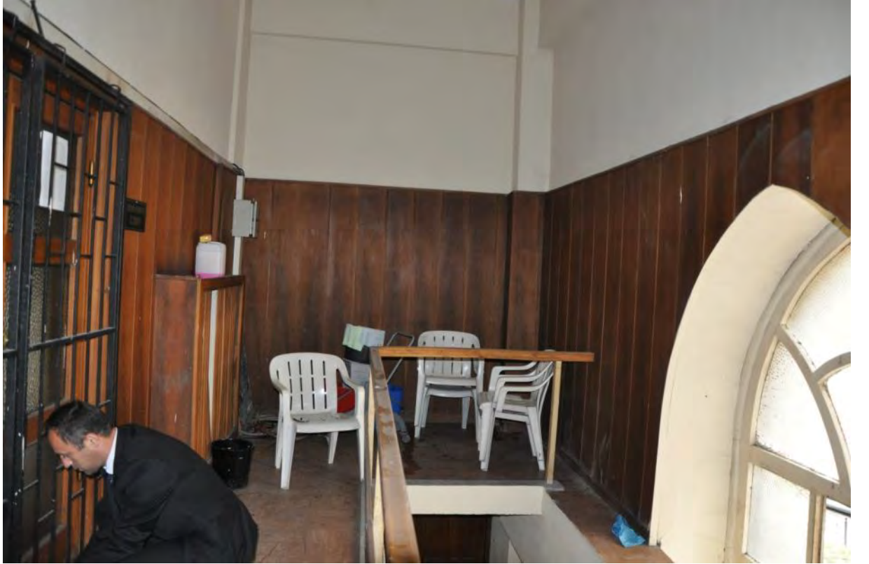
Şekil B.78: 214 Güneybatı duvarı
