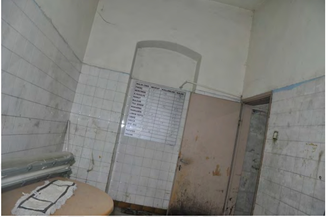
Şekil B.13: Z-06 Depo güneydoğu duvarı
