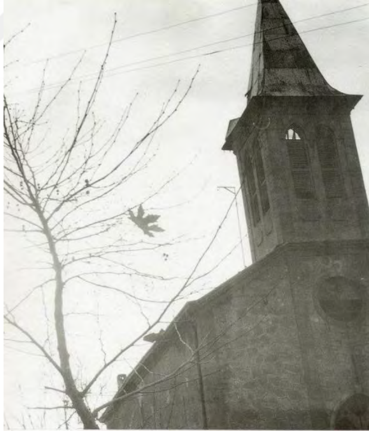
Şekil C.11 Yapının çan kulesinin yıkılmadan önceki halini gösteren fotoğraf(Cemal Turgay 1957)
