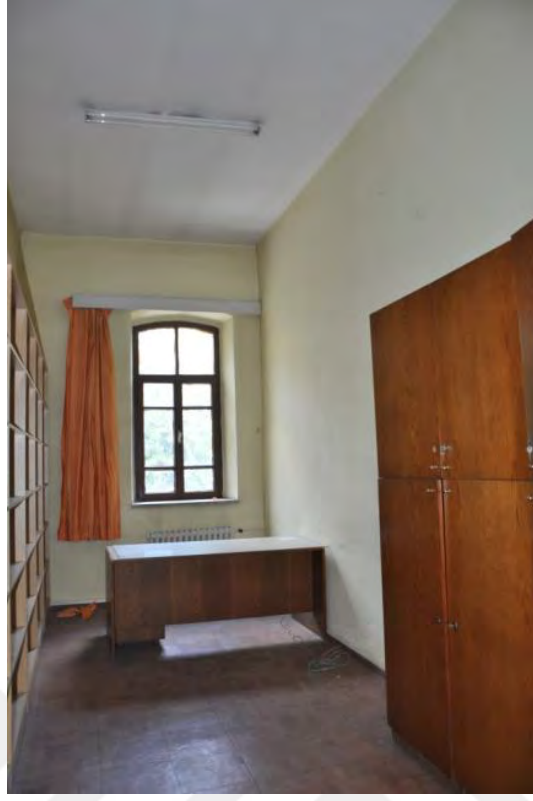
Şekil B.73: 210 Kuzeybatı duvarı
