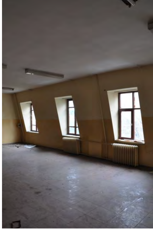
Şekil B.93: 314 Kuzeybatı duvarı
