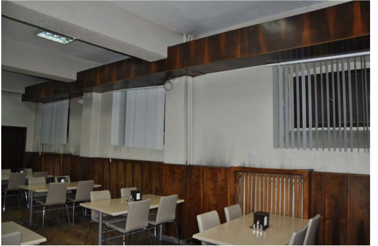
Şekil B.26: Z-15 Kuzeydoğu duvarı
