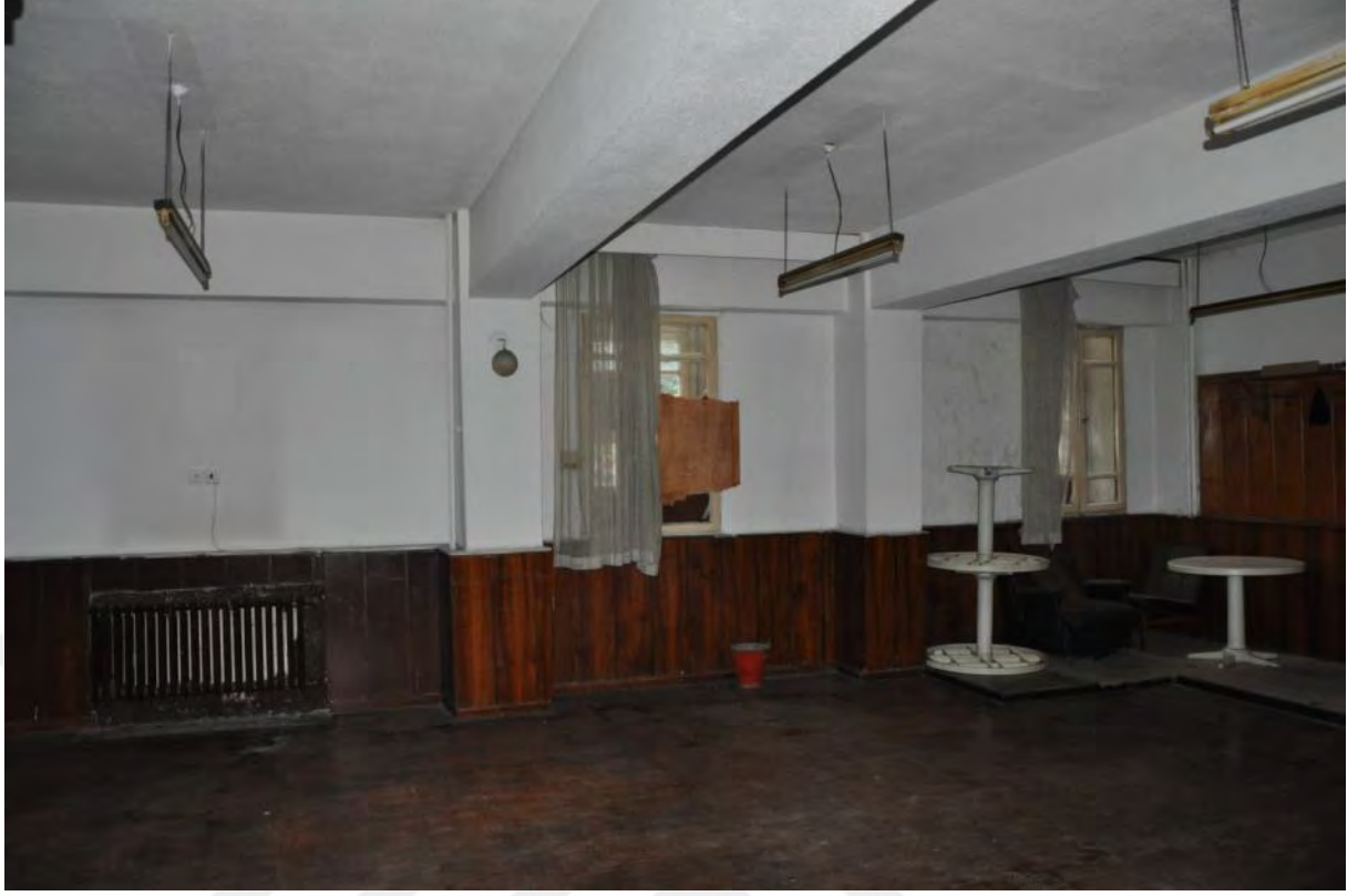
Şekil B.57: 125 Güneybatı duvarı
