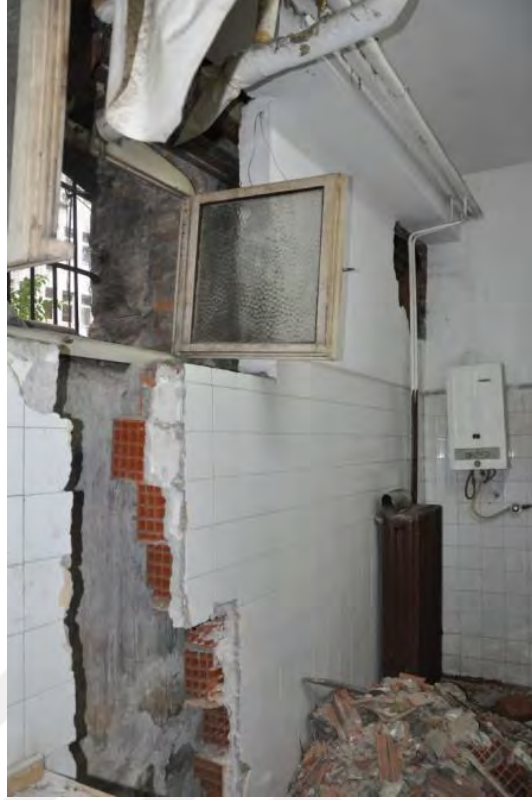
Şekil B.127 : Muhdes Delikli Tuğla duvar
