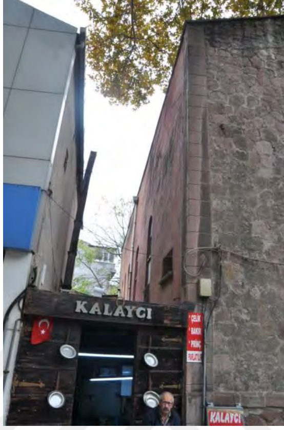
Şekil B.108 : Kuzeydoğu Cephesi 2018
