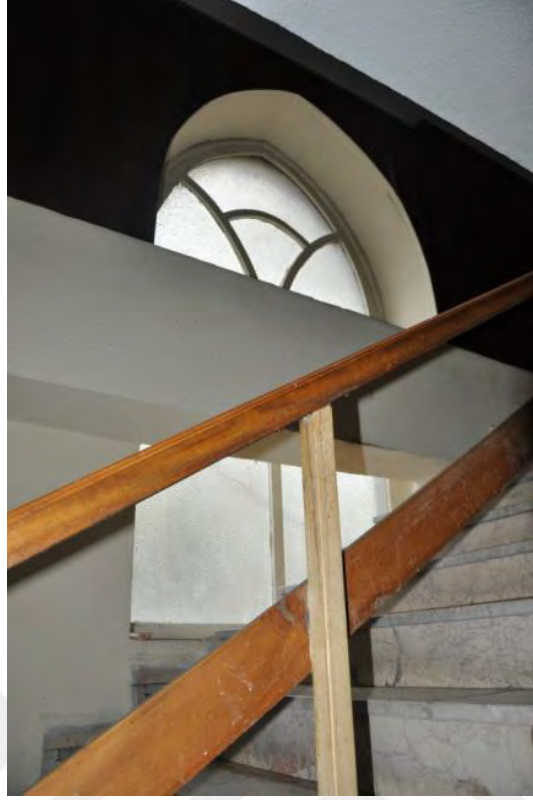
Şekil B.65: 128 Kuzeybatı duvarı
