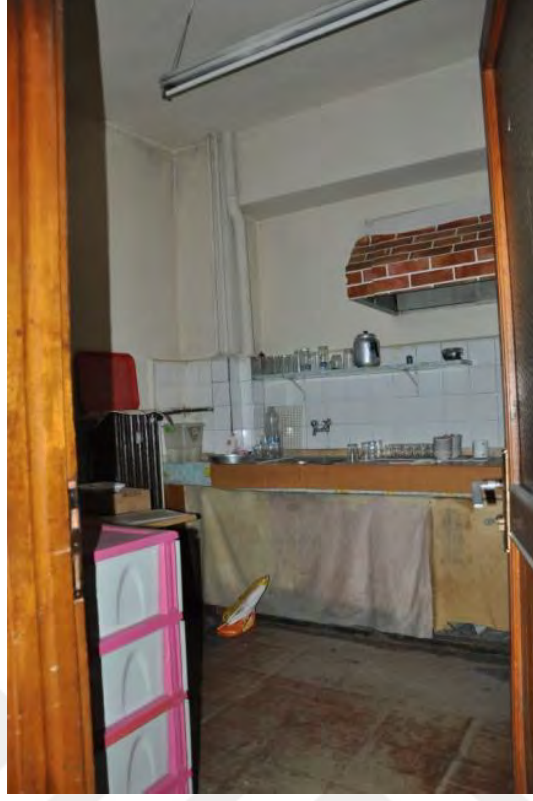
Şekil B.59: 126 Güneydoğu duvarı
