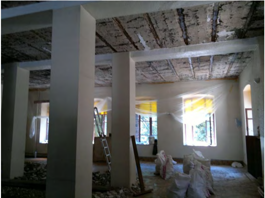
Şekil B.128 : Z-02 Mekanı Tavanında Putraller
