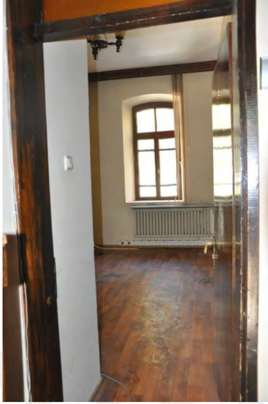
Şekil B.49: 118 Kuzeybatı duvarı
