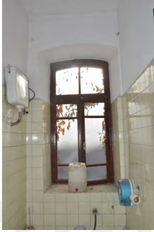
Şekil B.39: 106 Güneydoğu duvarı
