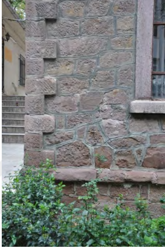
Şekil B.126 : Yapı Dış Taş Duvar Örgüsü
