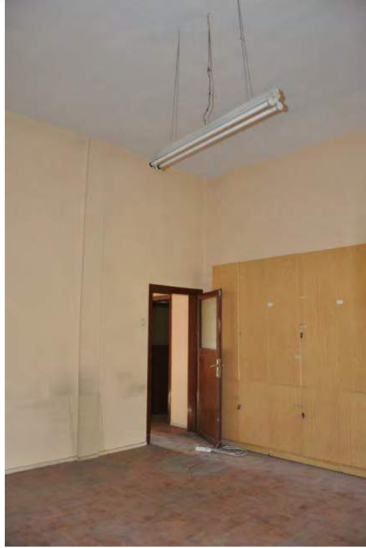
Şekil B.74: 211 Güneybatı duvarı
