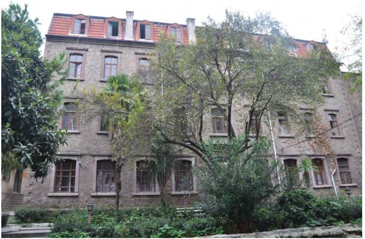
Şekil B.98 : Güneydoğu Cephesi 2018
