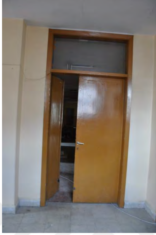
Şekil B.85: 301 Güneybatı duvarı
