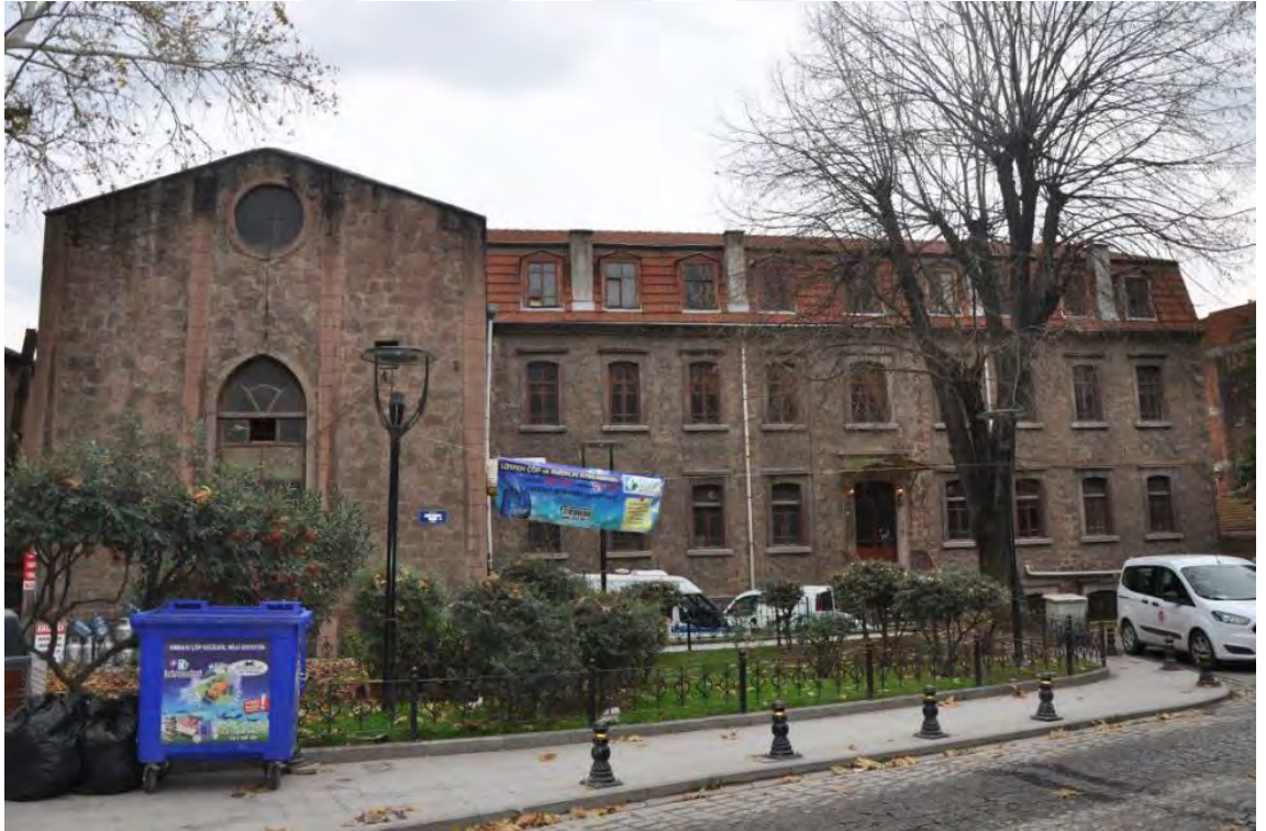
Şekil B.103 : Kuzeybatı Cephesi 2018
