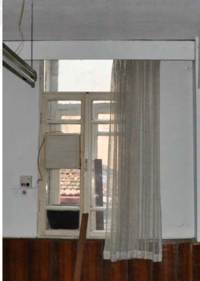
Şekil B.119 : P3 Penceresi İç Görünüşü Alt Kısım
