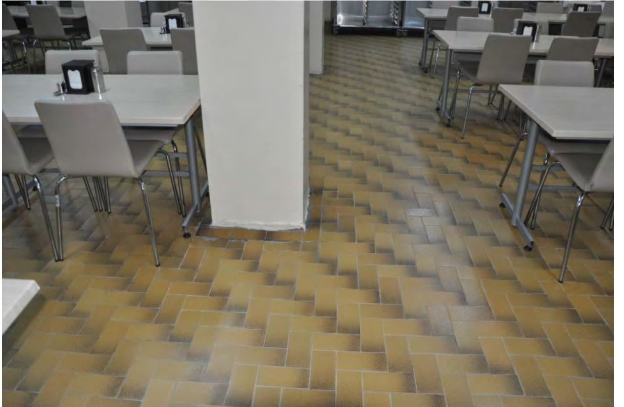
Şekil B.8 : Z-2 Döşeme görünümü
