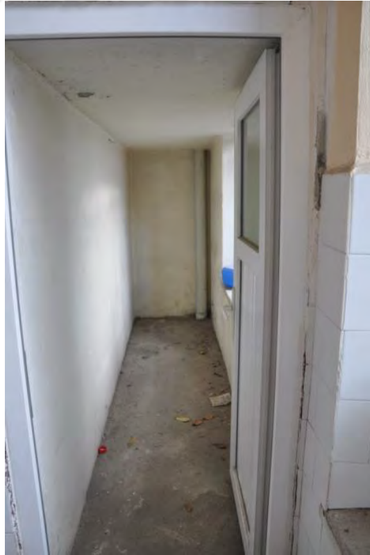
Şekil B.68: 205 Kuzeydoğu duvarı
