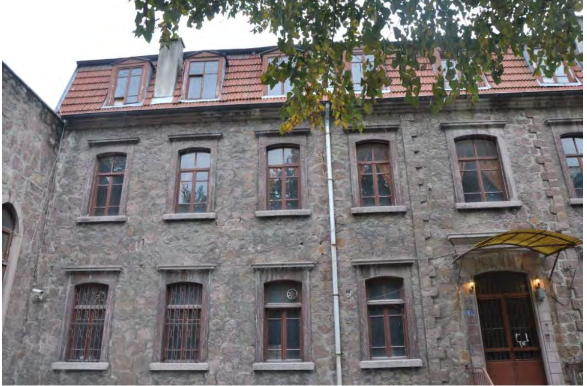
Şekil B.105 : Kuzeybatı Cephesi 2018
