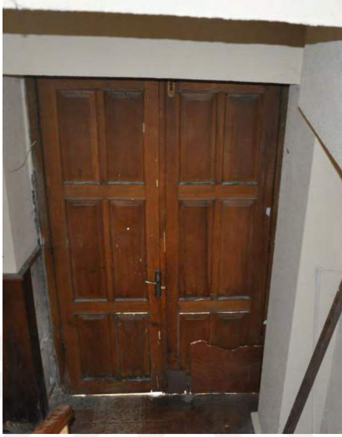
Şekil B.110 : Özgün Ahşap Giriş Kapısı İç Görünüşü
