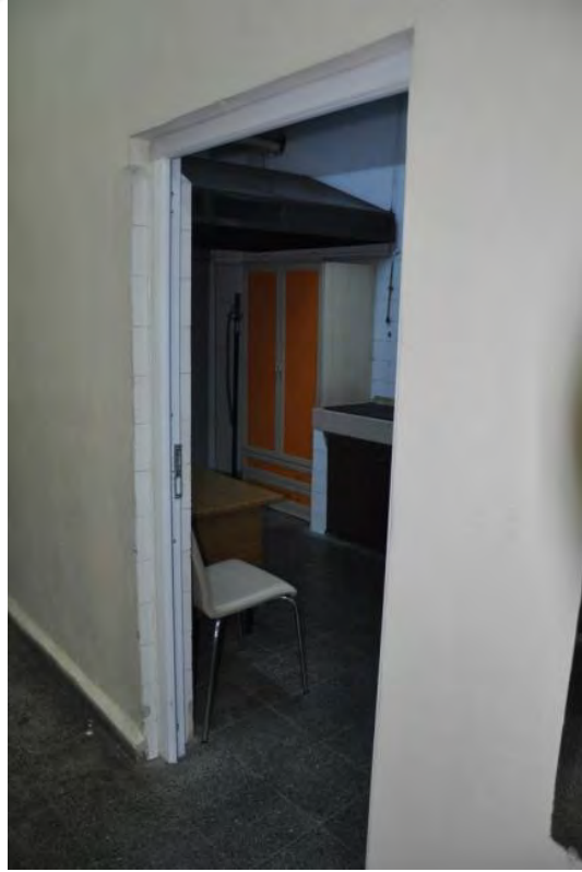
Şekil B.22: Z-17 Koridor Güneydoğu duvarı
