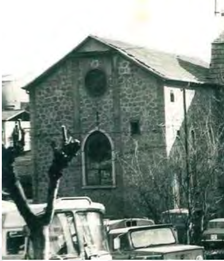
Şekil C.21 Yapının 1979 yılına ait kuzey cephe fotoğrafı detay (Kocaeli K.V.K.B.K.M.)
