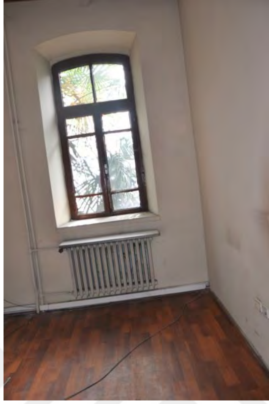
Şekil B.45: 114 Güneydoğu duvarı
