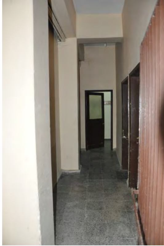
Şekil B.18: Z-12 Koridor Kuzeybatı duvarı
