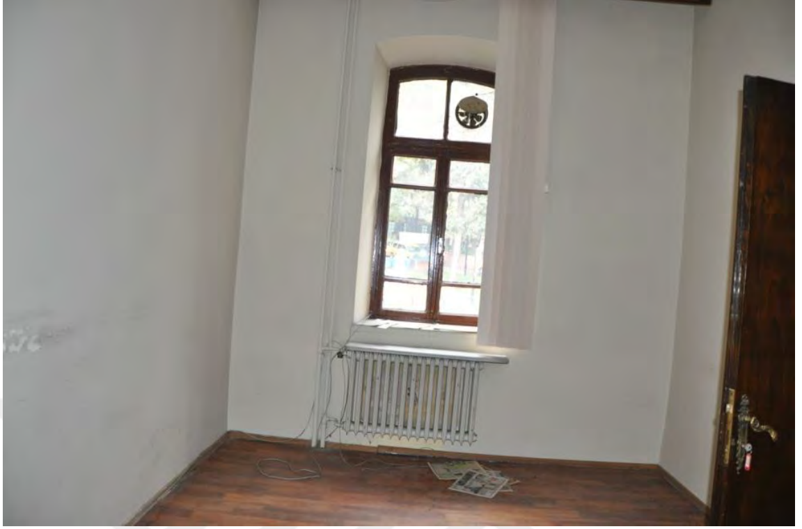
Şekil B.51: 122 Kuzeybatı duvarı
