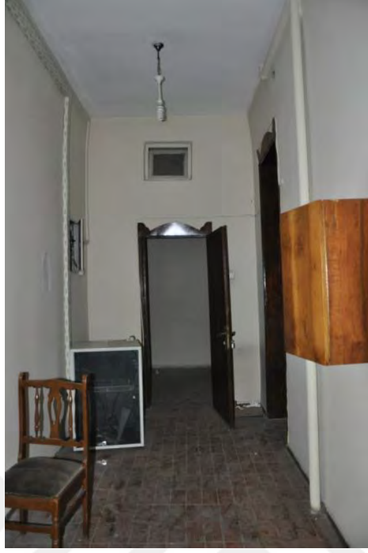
Şekil B.35: 102 Kuzeydoğu duvarı
