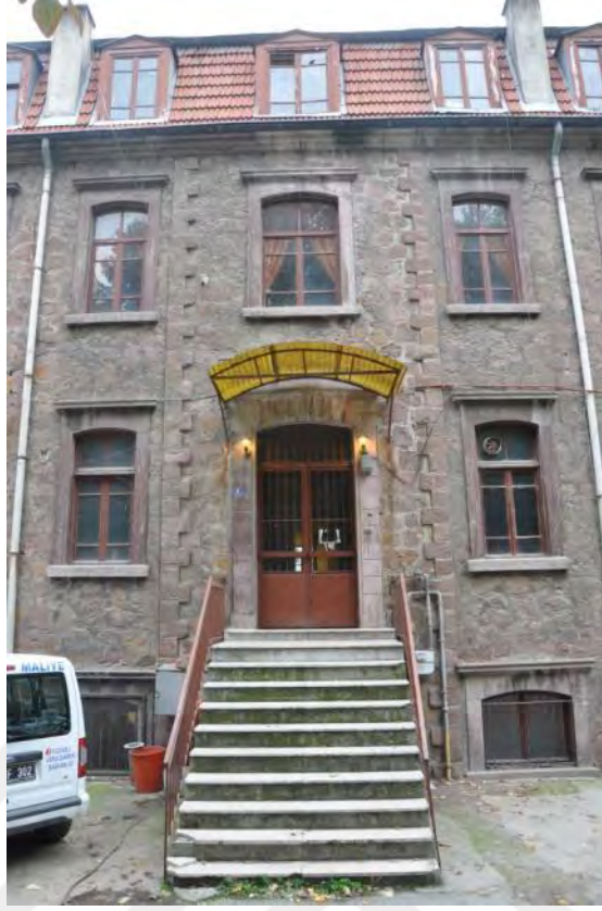
Şekil B.106 : Kuzeybatı Cephesi 2018
