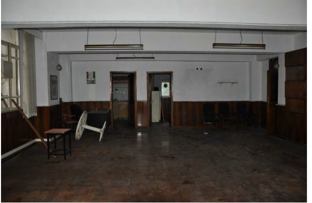
Şekil B.58: 125 Güneydoğu duvarı
