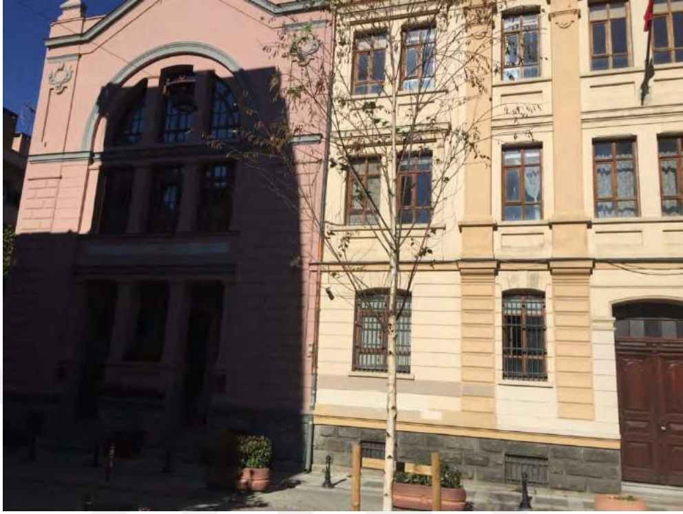
Şekil.D.4 Saint Euphémie Fransız Kız Okulu Taşlı Bayır sokak cephesi kilise cephesi 2019
