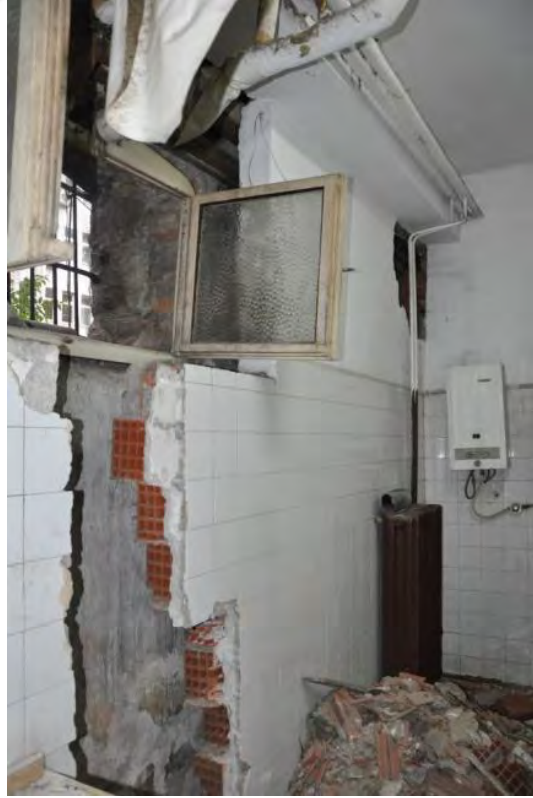
Şekil B.20: Z-12 Koridor Güneydoğu duvarı
