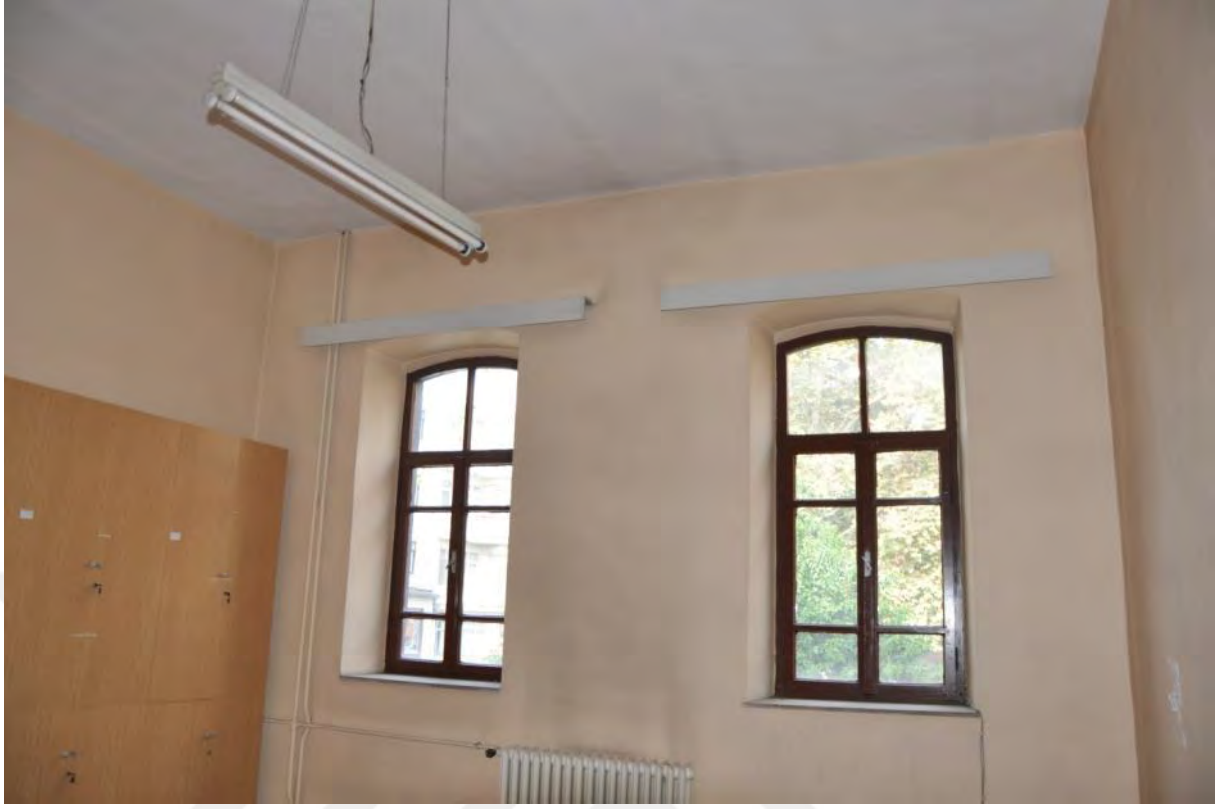
Şekil B.71: 208 Güneydoğu duvarı
