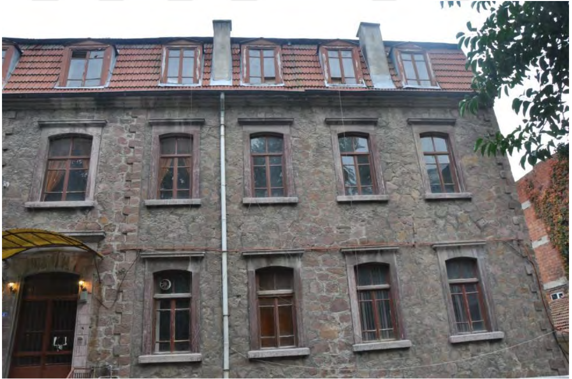
Şekil B.107 : Kuzeybatı Cephesi 2018
