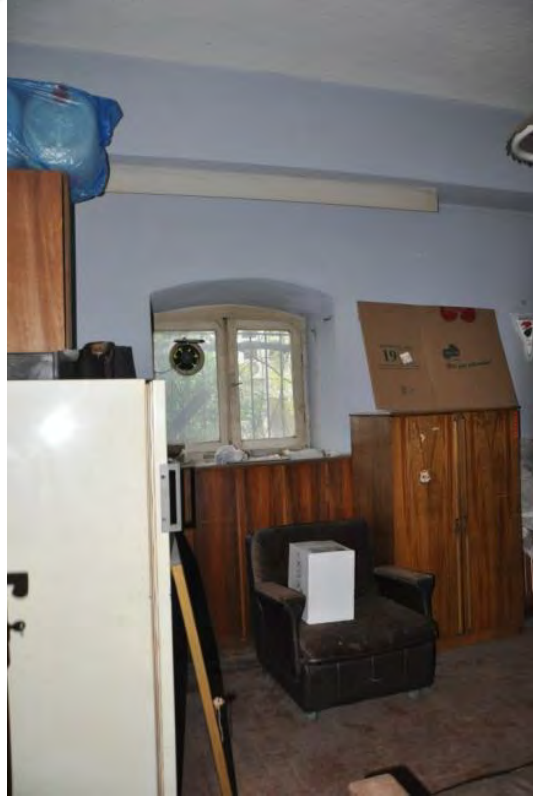
Şekil B.60: 127 Güneydoğu duvarı
