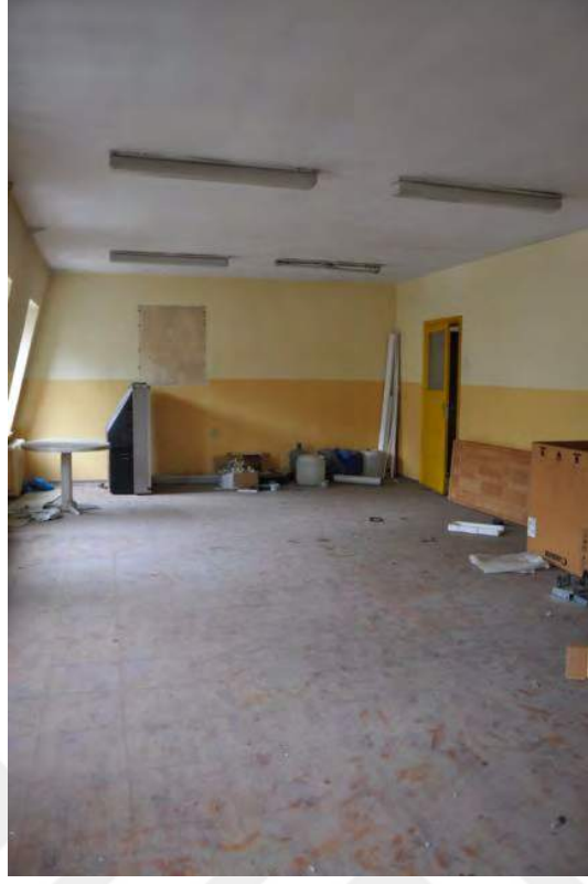
Şekil B.94: 314 Kuzeydoğu duvarı
