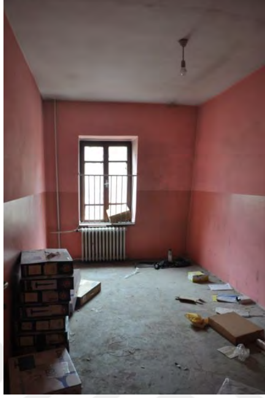
Şekil B.92: 313 Kuzeybatı duvarı
