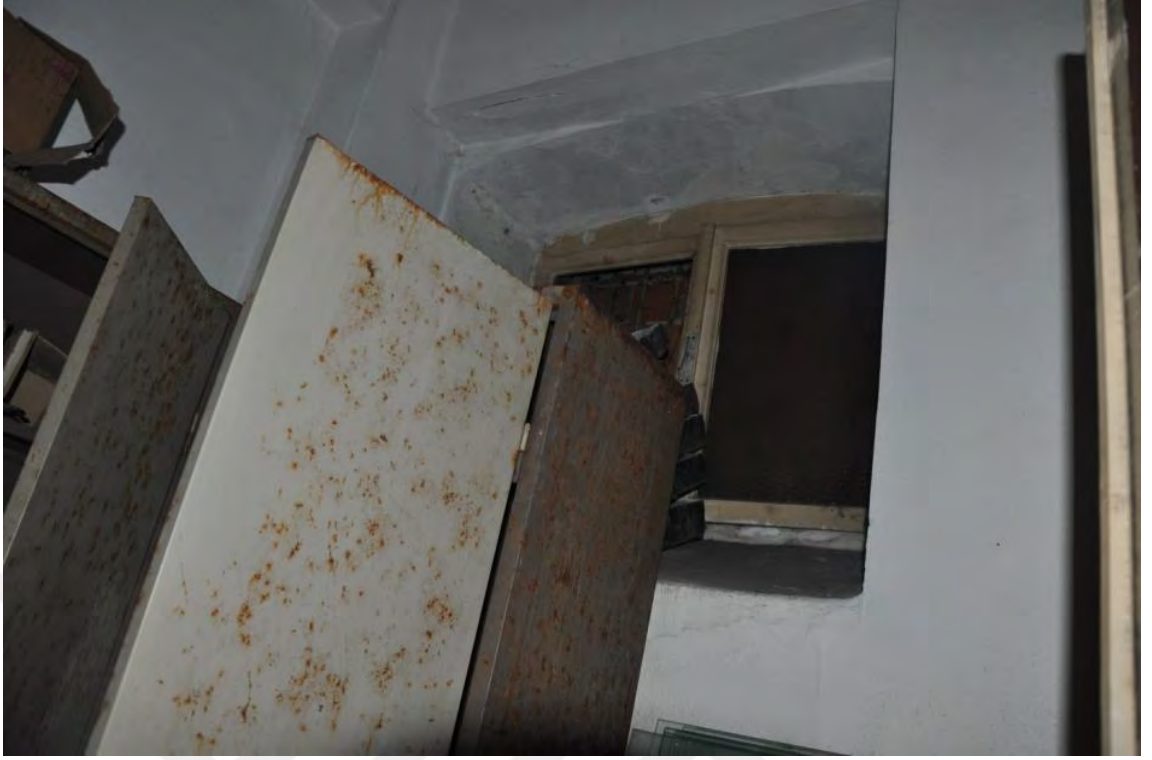
Şekil B.29: Z-16 Kuzeydoğu duvarı üzerindeki pencere
