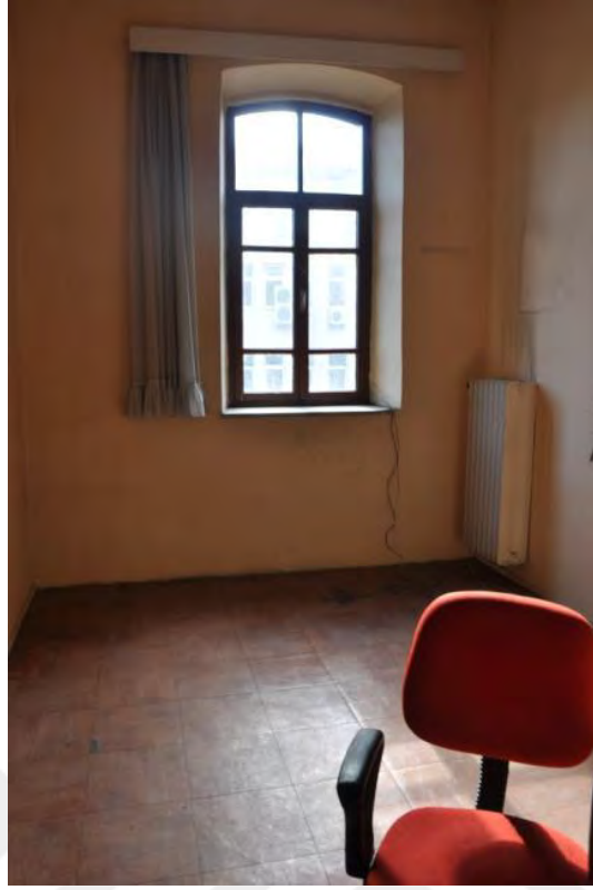
Şekil B.69: 206 Güneydoğu duvarı
