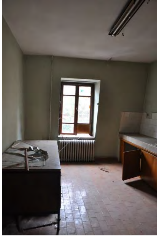
Şekil B.95: 315 Kuzeybatı duvarı
