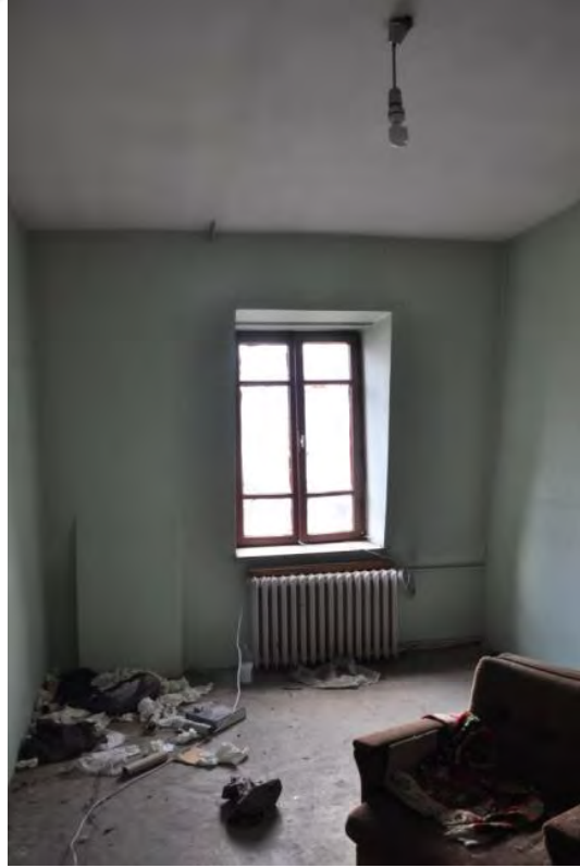
Şekil B.88: 307 Güneydoğu duvarı
