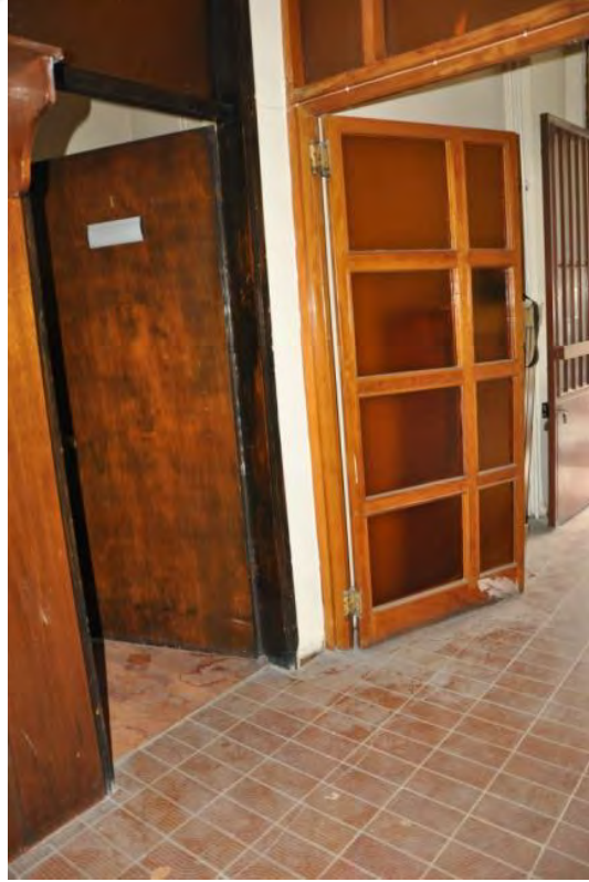
Şekil B.32: 103 Giriş kapısı
