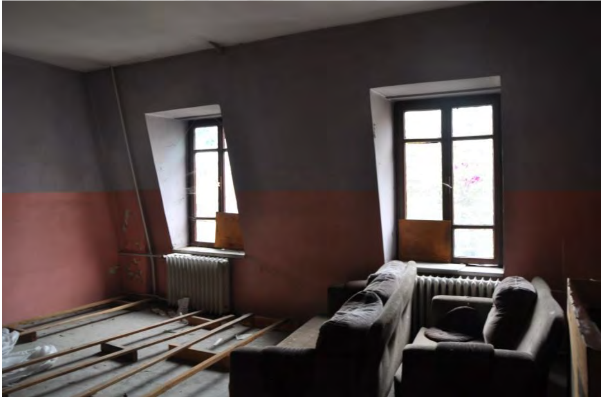
Şekil B.91: 312 Kuzeybatı duvarı
