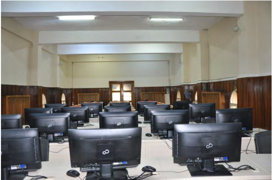
Şekil B.80: 215 Kuzeybatı duvarı
