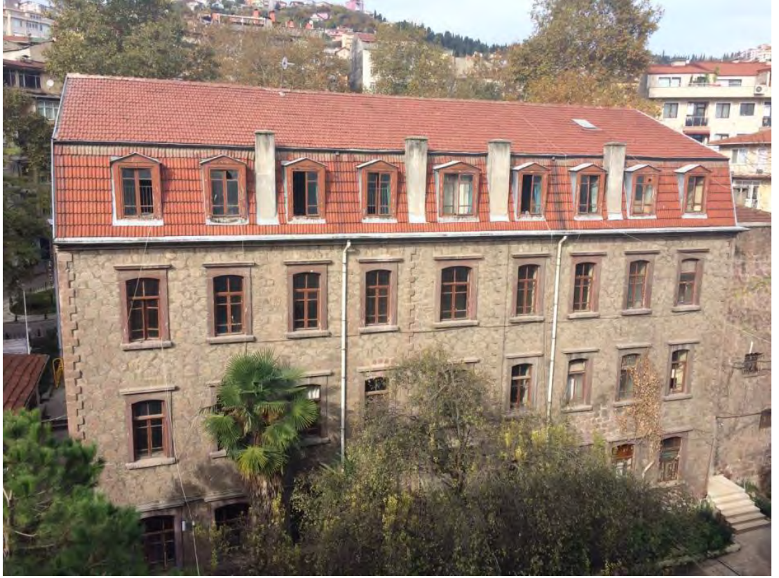
Şekil B.130 : Ana Kütle Uzerinde Marsilya Kiremit Çatı
