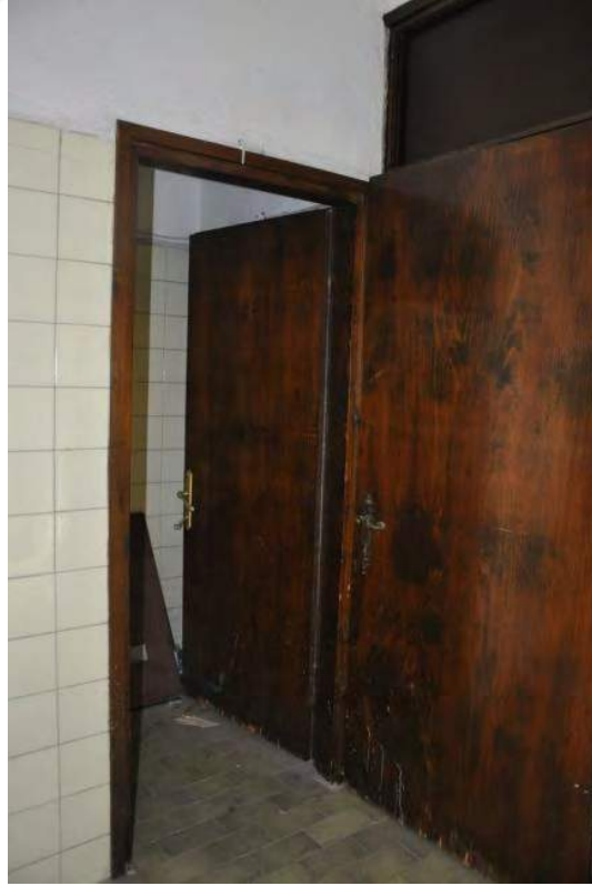
Şekil B.38: 105 Kuzeybatı duvarı
