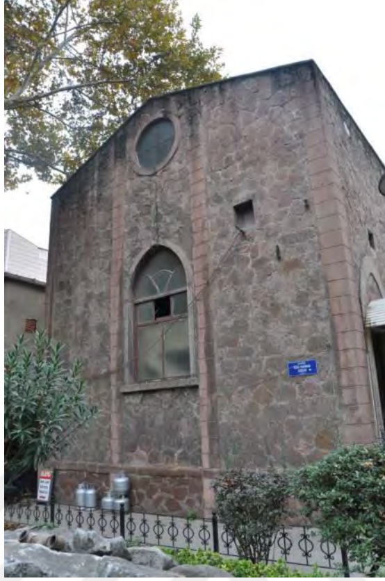
Şekil B.104 : Kuzeybatı Cephesi 2018
