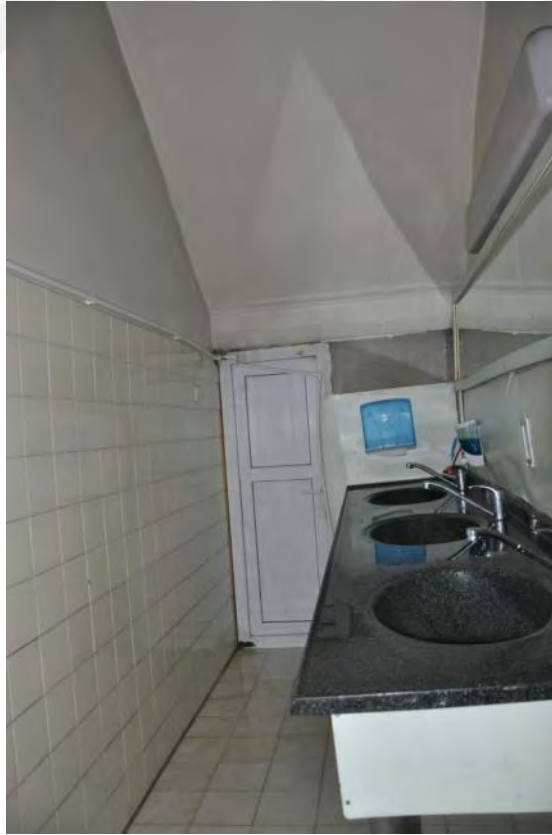
Şekil B.14: Z-07 WC güneydoğu duvarı
