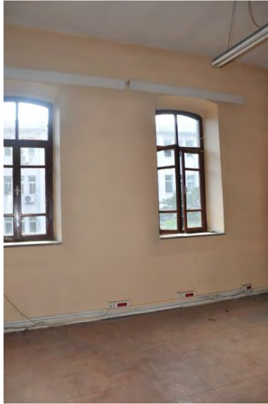
Şekil B.72: 209 Güneydoğu duvarı
