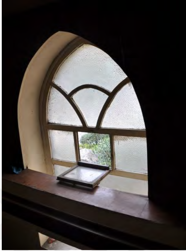
Şekil B.79: 214 Kuzeybatı duvarı
