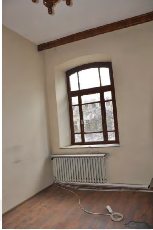
Şekil B.43: 111 Güneydoğu duvarı
