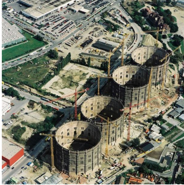
Şekil 5.1.37: Viyana Gazometleri inşaatı (URL-47)
