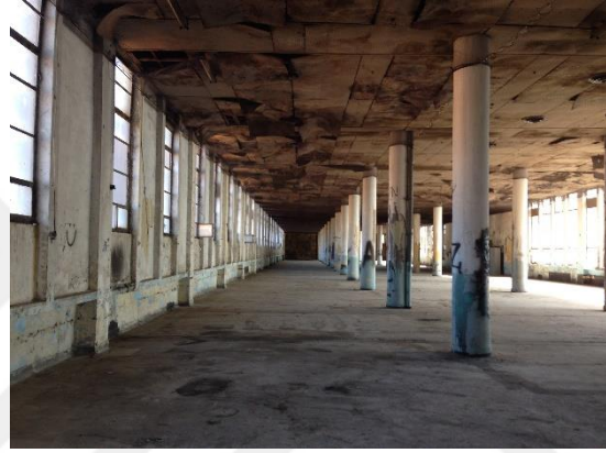
Şekil4.2.6: I No'lu Fabrika Binası iç mekan görünüşü, 2015, (Fotoğraf: Dilara Piran)
