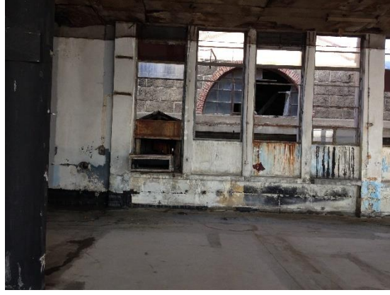
Şekil 4.2.5 : I No'lu fabrika binası ve 2 No'lu fabrika binası arası bağlantı ilişkileri, 2015 (Fotoğraf: Dilara Piran)
