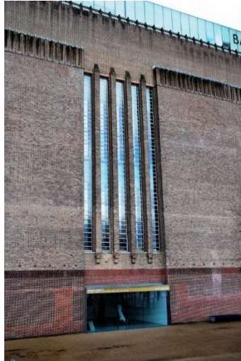
Şekil 5.1.3: Cephe görünüşü (Fotoğraf: Javier Gutierrez Marcos) (URL-33)
