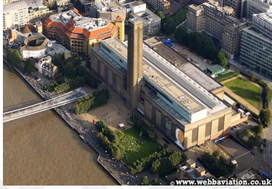
Şekil 5.1.1: Tate Modern Hava Fotoğrafi/ 2016 Switch House binasının açılışından önce (URL-32)
